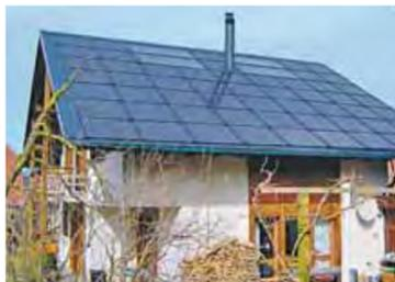
Tetto solare con 53 moduli per la produzione di corrente elettrica e quattro collettori per l'acqua calda.
