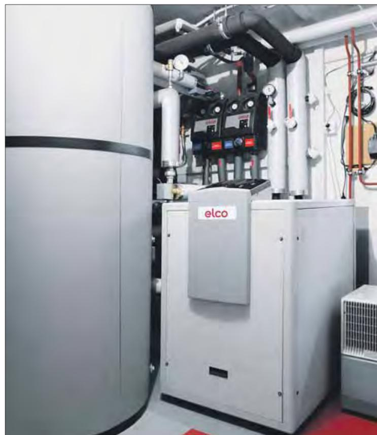
**Ecco la stanza in cantina che ospita la pompa di calore salamoia-acqua Elco Aquatop T10 e l'accumulatore combinato dell'impianto solare Elco Auron DF.**
