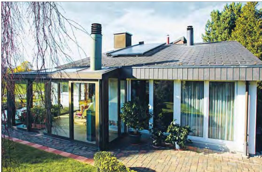
**Il collettore a tubi sotto vuoto sul tetto inclinato della casa unifamiliare dei Ruckstuhl riscalda l'acqua sanitaria e supporta l'impianto di riscaldamento.**
