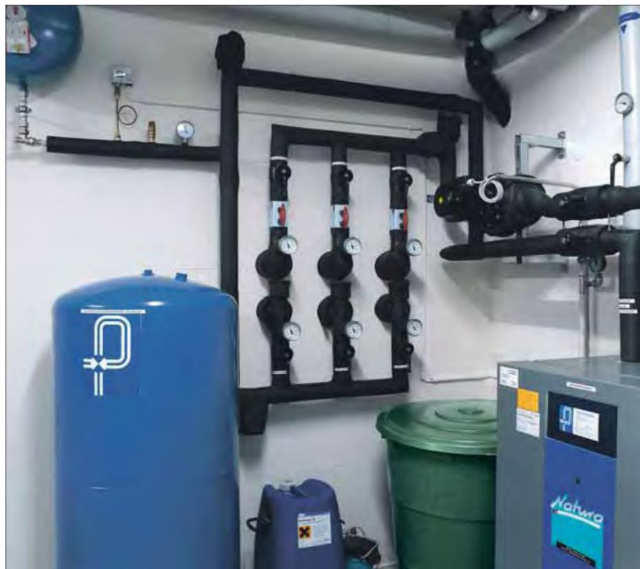
**Alta tecnologia in cantina al posto della cisterna del gasolio: in queste due foto si vedono i componenti necessari all'interno della casa per il solare termico, la pompa di calore con sonda geotermica e l'impianto fotovoltaico.**
