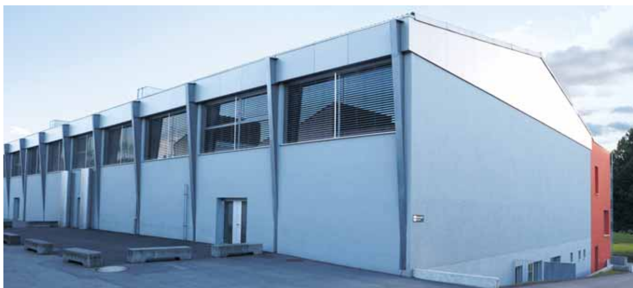
La palestra ingrandita e rimodernata presso la scuola Marly Grand-Pré ha riacquisito il suo smalto da quando ne è stata coibentata la facciata e sono state installate nuove finestre, collettori solari sul tetto e un'illuminazione a basso consumo.
