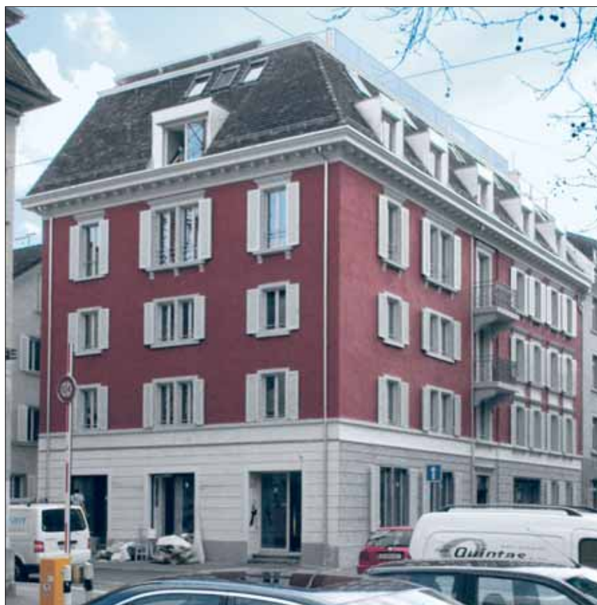
Il condominio al numero 28 di Magnusstrasse a Zurigo è stato completamente risanato in appena sei mesi e addirittura vi è stato aggiunto un piano mansardato fatto di elementi prefabbricati.
