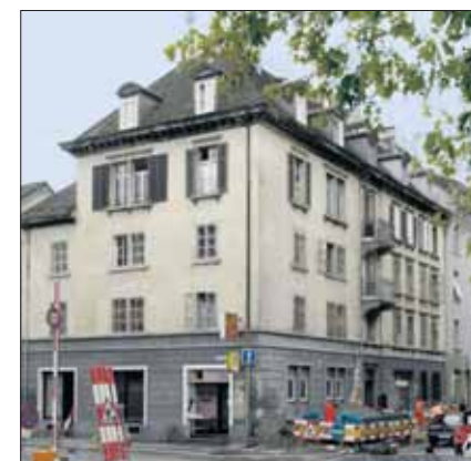
Il condominio al numero 28 di Magnusstrasse a Zurigo è stato completamente risanato in appena sei mesi e addirittura vi è stato aggiunto un piano mansardato fatto di elementi prefabbricati.
