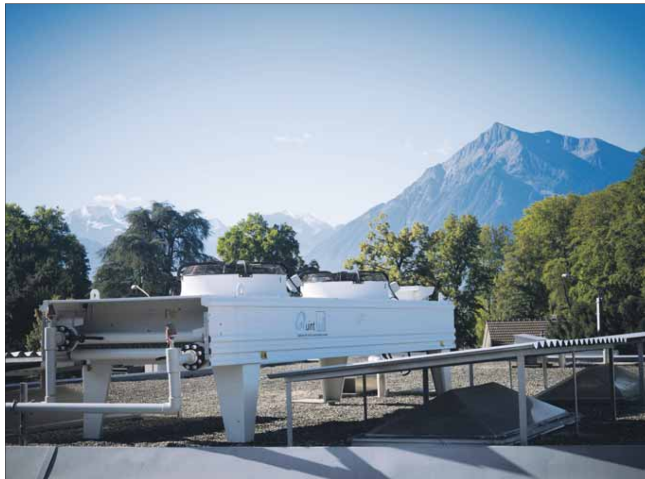
L'impianto di raffreddamento installato sul tetto rilascia nell'ambiente il calore perduto non utilizzato, ma a partire da una temperatura esterna di 15 gradi provvede praticamente gratis al raffreddamento della sala stampa e dei processi di stampa. (Foto: Regula Roost)
