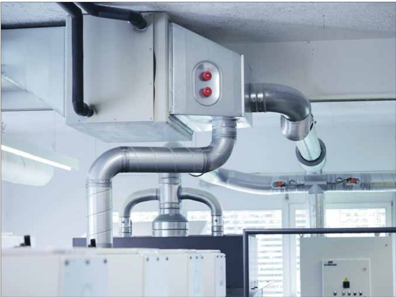
Lo scambiatore di calore sopra l'uscita della R505LV sottrae energia all'aria di scarico del processo di asciugatura e di aspirazione delle polveri delle due macchine e la mette a disposizione dell'aria di alimentazione per il monoblocco destinata a riscaldare o raffreddare la sala stampa. Un sistema a bassissimo consumo di energia.
