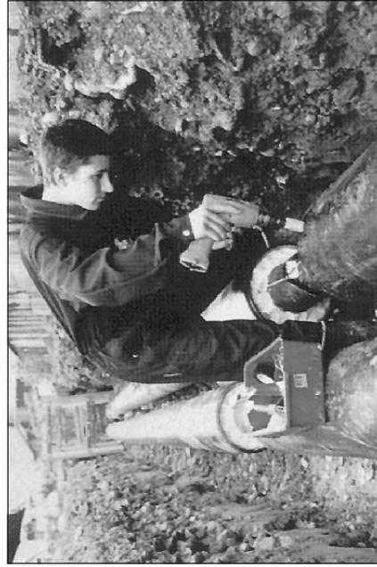
*Successiva posa dell'isolamento termico in cantiere in corrispondenza delle saldature.*
