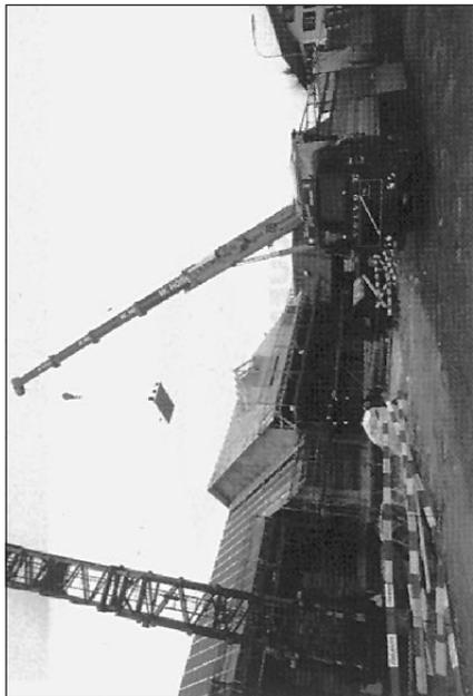
Posa delle componenti delle caldaie mediante autogrù.
