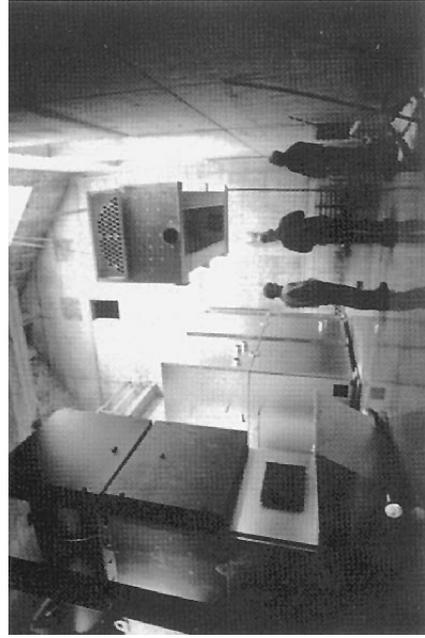
Impianto di combustione a carica inferiore nella centrale di riscaldamento (montaggio grezzo).
