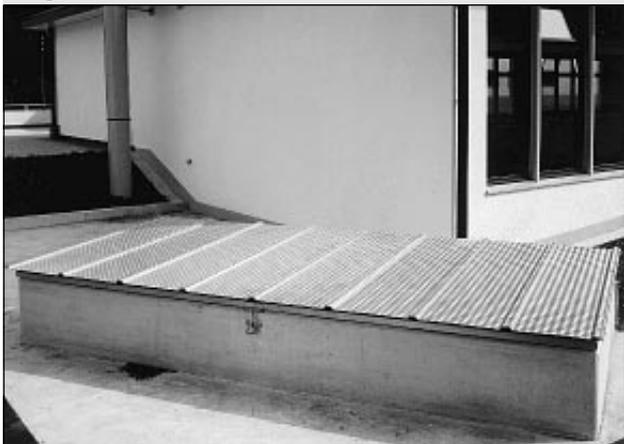
Il coperchio del silo può essere realizzato in più parti, così da aumentarne la stabilità e, grazie al minor peso di ogni sua parte, di facilitarne l'uso. Inoltre, con questa disposizione, i trucioli di legna non cadono a lato dell'apertura di riempimento e non vi è il pericolo che il coperchio venga sottoposto a carico eccessivo quando i trucioli slittano dal camion in un blocco compatto.
