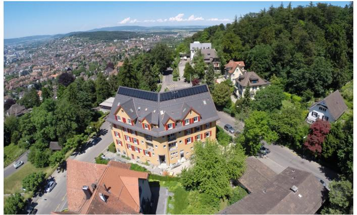
Il calore solare fornisce un importante contributo per la rigenerazione del terreno caratterizzato da un uso intensivo delle sonde geotermiche: sul tetto dell'Haus (studentato) Justinus di Zurigo sono stati installati 70,5 m<sup>2</sup> di assorbitori non smaltati. Le sei sonde geotermiche, ciascuna lunga 380 m, possono essere rigenerate con il calore solare. Foto: kämpfen zinke+partner
