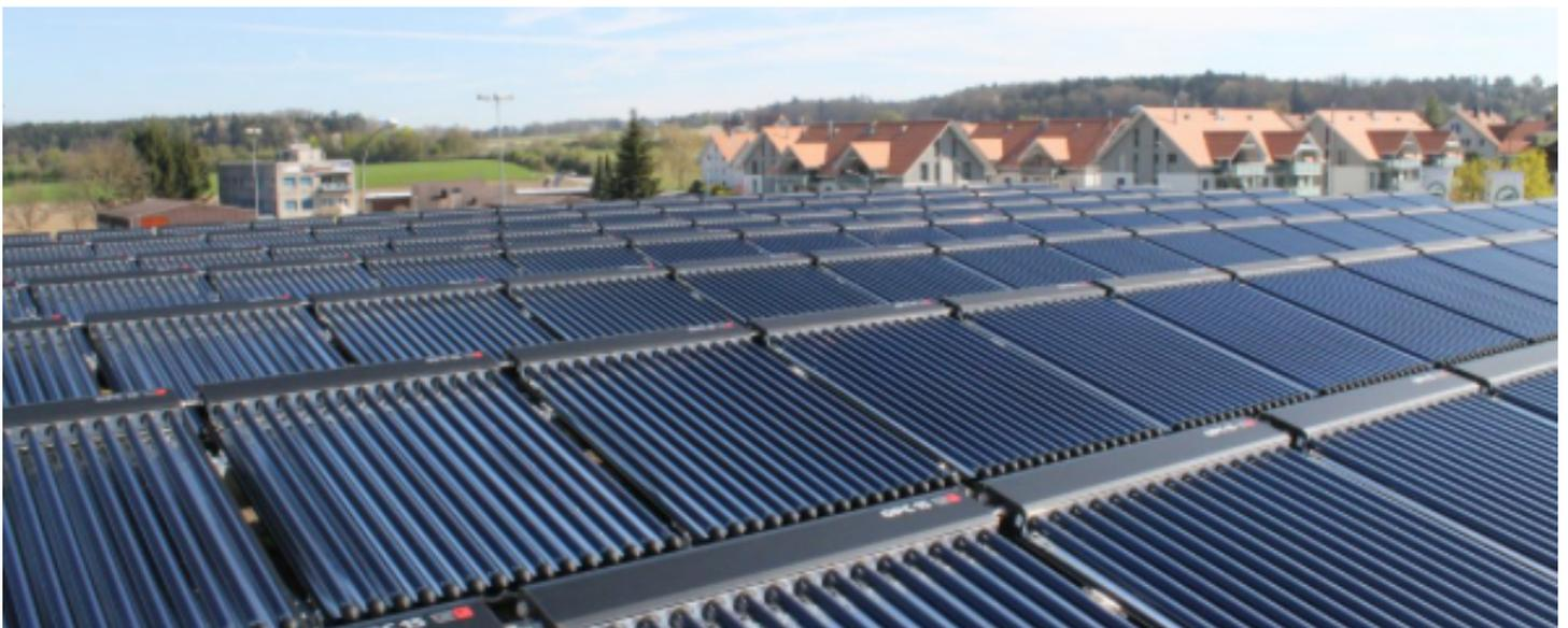
La rete di riscaldamento di Schüpfen (BE) è una delle poche in Svizzera che sfrutta il calore solare per una rete di riscaldamento. La rete di riscaldamento distribuisce attualmente il calore proveniente da un impianto di riscaldamento alimentato da trucioli e da un impianto termico solare con 460 m<sup>2</sup> di collettori a nove esercizi commerciali e a 630 appartamenti. Foto: Wärmeverbund Lyssbach Schüpfen AG
