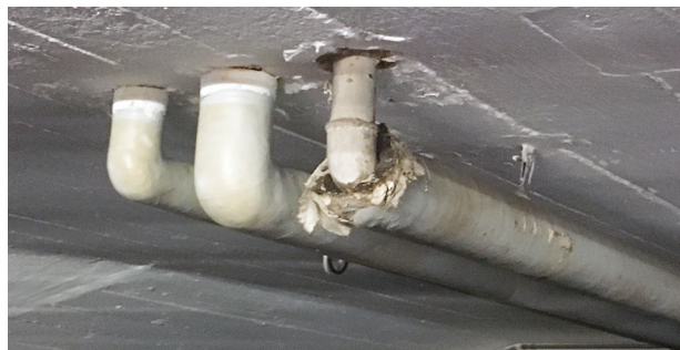
Riparazione di isolamenti termici difettosi.
