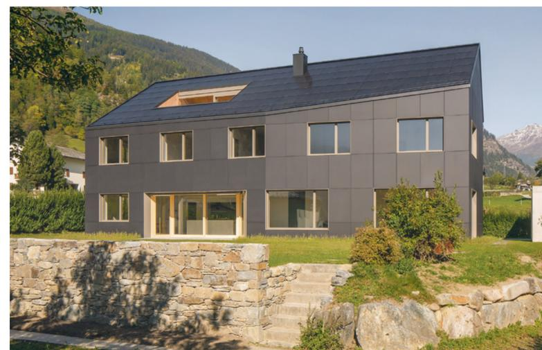
L'edificio «Winter Plus Energy» Sol'CH a Poschiavo (GR) è un esempio premiato di fotovoltaico integrato. La totalità del suo involucro, quindi anche la facciata nord, è costituita da moduli fotovoltaici. Foto: Nadia Vontobel Architekten GmbH
