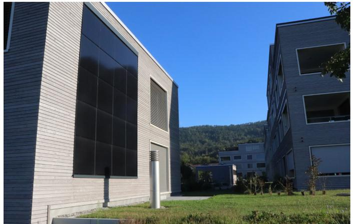
La potenza totale dell'impianto fotovoltaico è di 164 kWp, di cui 120 kWp sono installati sul tetto e 44 kWp su davanzali e pareti delle case. Secondo una stima approssimativa, questi ultimi contribuiscono per circa il 20% alla resa di energia solare. Foto: B. Vogel
