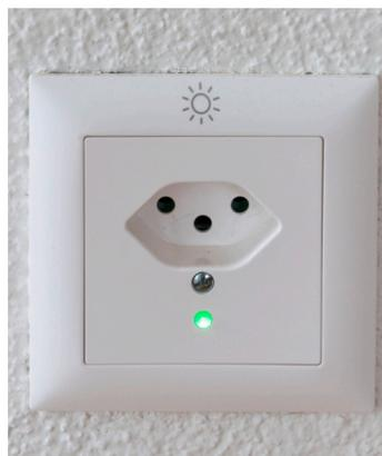
Una spia luminosa verde segnala ai residenti quando è disponibile energia elettrica fotovoltaica autoprodotta. In questo caso, l'energia solare può anche essere prelevata direttamente dalla «presa solare». Foto: Rapporto finale dell'UFE
