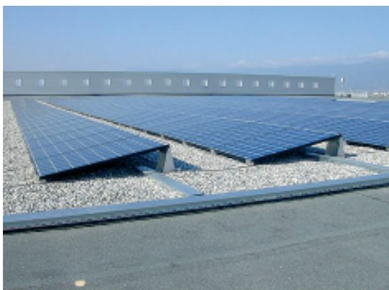
**Figur 16:** 70-kWp-Flachdachanlage Palexpo Genf (Bildquelle: NET AG)
