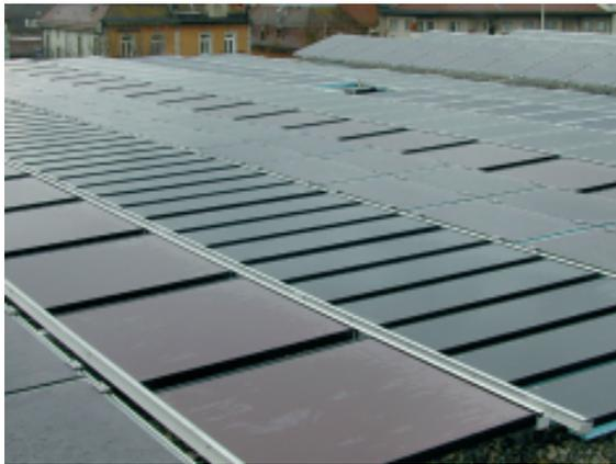
**Figur 14:** PV-DünnFilmTest (Bildquelle: NET AG)
