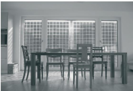
**Figur 3:** *Passivhaus Nicole Schmölzer:* Neuartige Schiebeläden mit integrierter Photovoltaik ergeben ansprechende Lichteffekte kombiniert mit hoher Funktionalität
