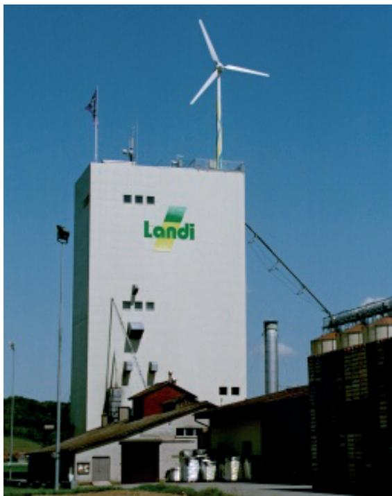
**Figur 2:** Eine 7-kW-Windkraftanlage auf dem Silo der landwirtschaftlichen Genossenschaft in Marthalen
