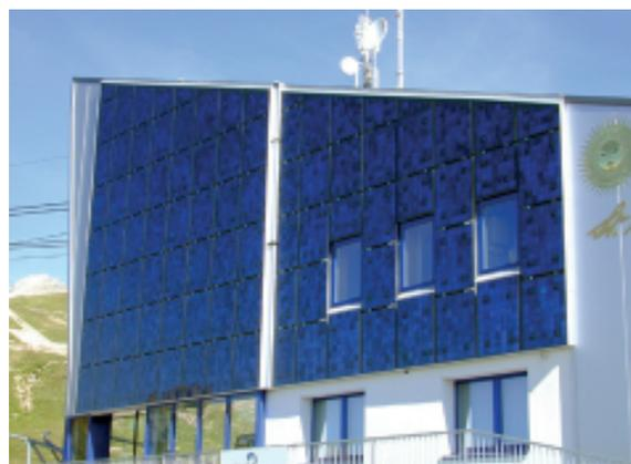
**Figur 17:** 9.7 kWp-Fassade der Piz Nair Seilbahn Talstation (Bildquelle: NET AG)
