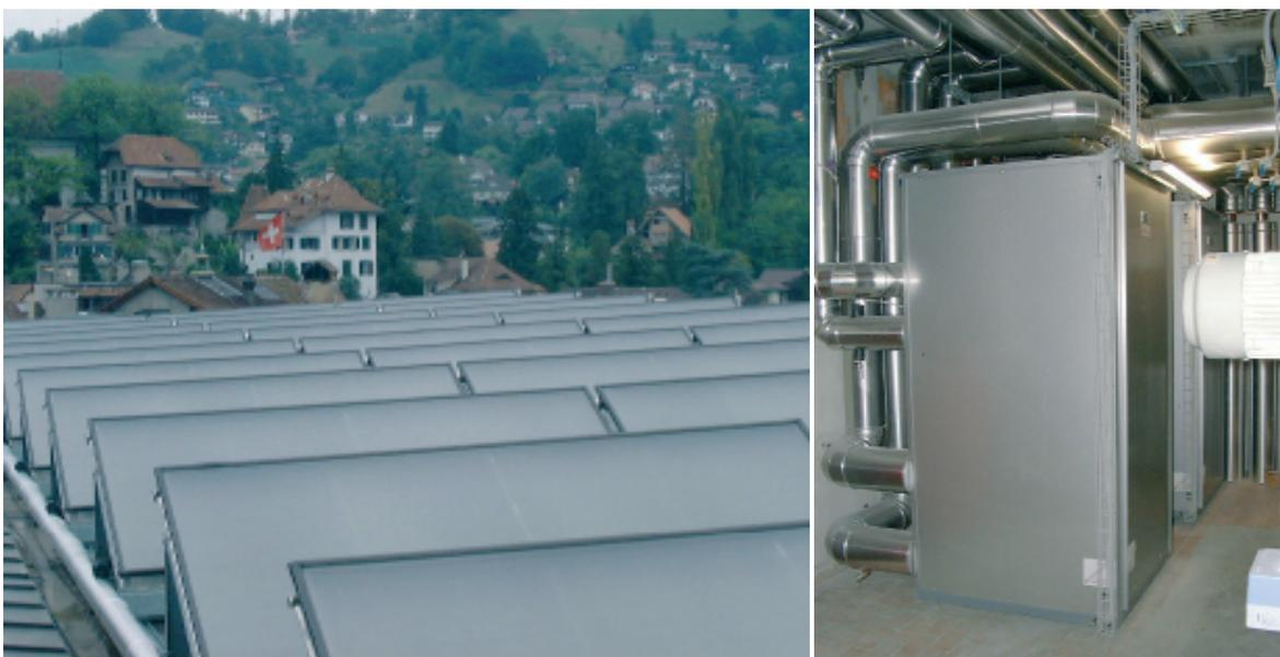
**Figure 10 :** Banque Cantonale Bernoise à Thounne : 100 m<sup>2</sup> de capteurs en toiture (à gauche) et 2 machines frigorifiques à absorption (couple H<sub>2</sub>O–LiBr) de 46 kWfroid chacune (à droite)
