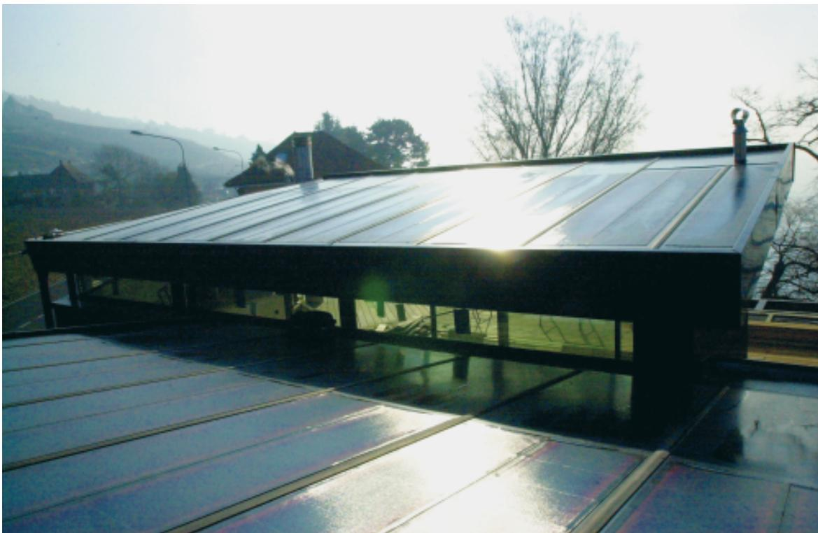
**5.5-kWp-Dachintegration Freestyle® mit Dünnschichtzellenmodulen**
