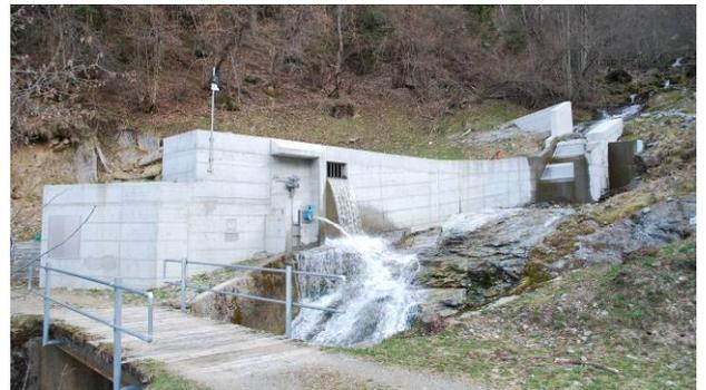
La petite centrale hydraulique d'Anzonico-Vigne exploite une dénivellation de 430 mètres pour une puissance de 230 kW. Elle utilise l'eau du ruisseau « Ri di Suàisa », situé sur le flanc gauche de la vallée de la Léventine.
