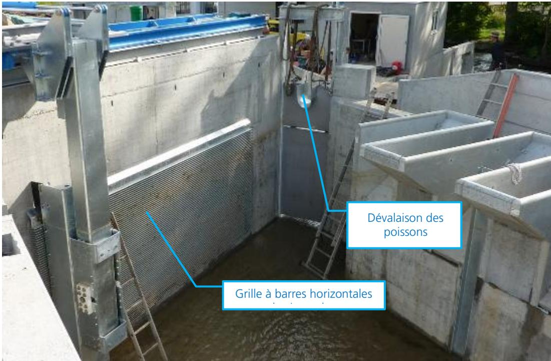
Fig. 6-4 Grille à barres horizontales avec by-pass à poissons à la centrale Hämmerli
