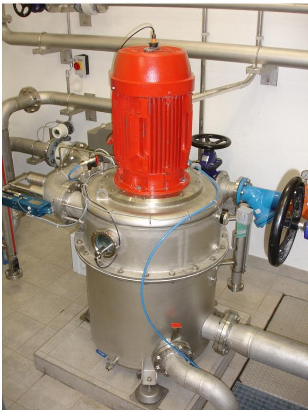
**Fig. 2-24 Centrale de Fällenden (CH) équipée d'une turbine Pelton à contre-pression (17kW) [21]**
