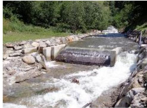
**Fig. 2-5 Tyrolienne avec passe à poissons (en rive droite) et canal de purge (en rive gauche), [6]**
