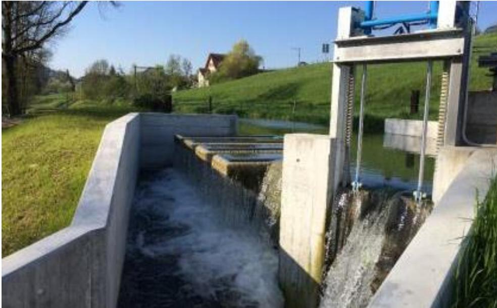
**Fig. 2-15** Réservoir en amont avec déversoir en touches de piano comme déversoir de décharge
