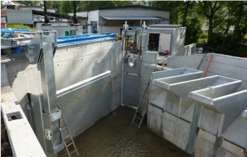
Fig. 2-8 Grille à barreaux horizontaux (à gauche de l'image) à la centrale Hämmerli
