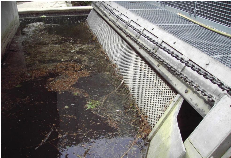
Fig. 2-11 Grille à tôle perforée avec dégrilleur horizontal entraîné par un mécanisme à chaîne
