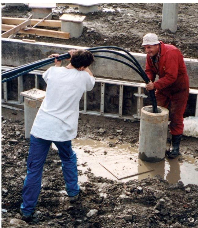
Insertion des sondes géothermiques dans les pieux de fondation de la future école.
