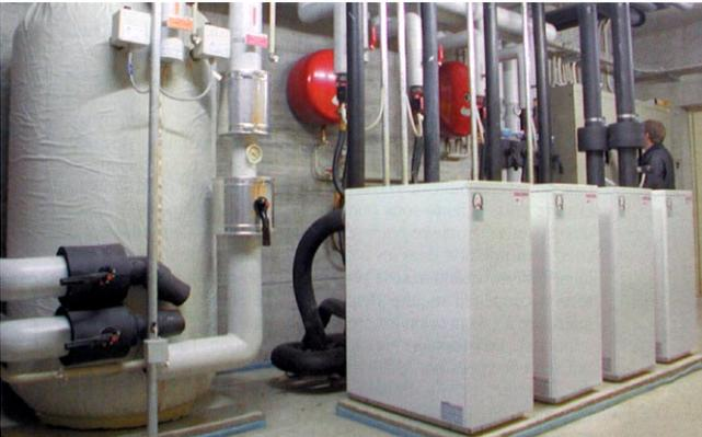
Local technique avec les quatre modules de pompes à chaleur en cascade de 15 kW chacun.
