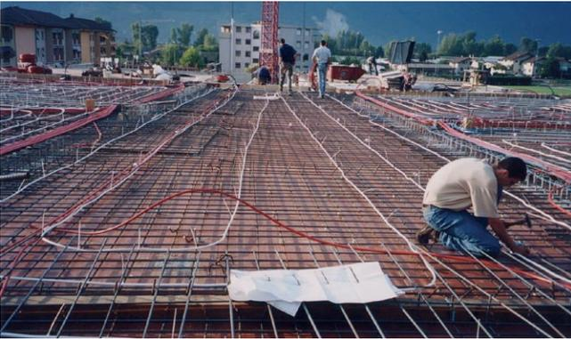
Installation du réseau de chauffage intégré dans la dalle de toiture.
