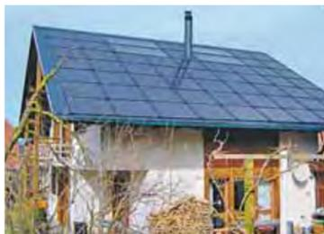
Toit solaire avec 53 modules pour la production de courant et 4 collecteurs pour l'eau chaude.
