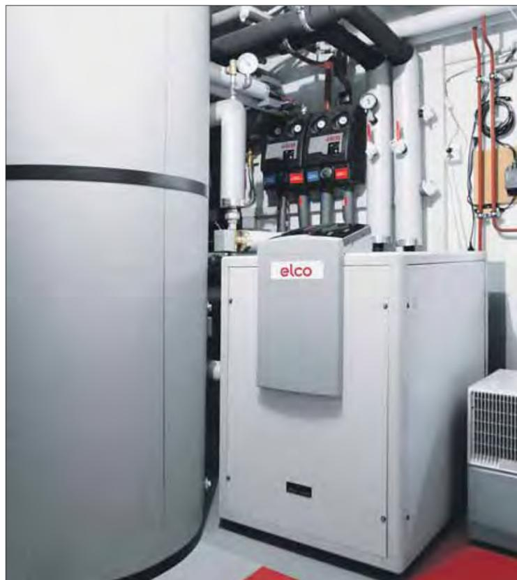
Coup d'œil dans la chaufferie avec la pompe à chaleur sol-eau Elco Aquatop T10 et l'accumulateur combiné de l'installation solaire Elco Auron DF.
