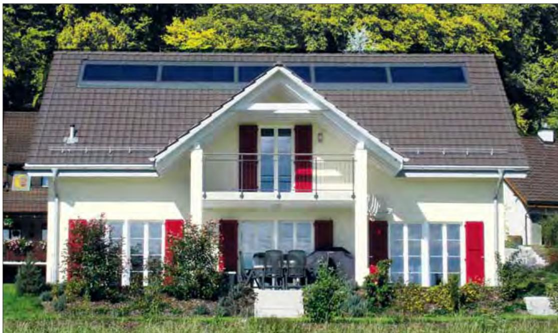
Lorsque l'installation doit également servir d'appoint au système de chauffage, un minimum de 15 mètres carrés de capteurs solaires est requis. En revanche, quatre à six mètres carrés suffisent pour couvrir les 70 % des besoins en eau chaude sanitaire d'une famille de quatre personnes.
