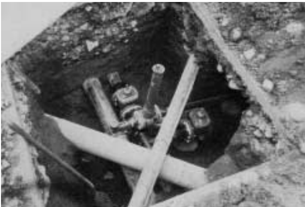
Figure 6.19: Informations complémentaires sur les éléments de réseaux sous la forme de photos gérées par HyperBird.
