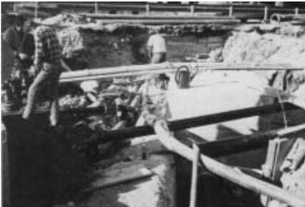
Figure 6.18: Informations complémentaires sur les éléments de réseaux sous la forme de photos gérées par HyperBird.
