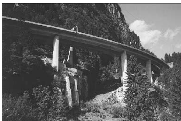
Figure 1.3 L'une des principales applications du béton armé : les ponts modernes
