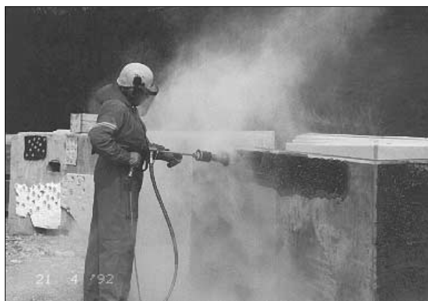
Figure 6.6 Jet d'eau à très haute pression, 2'500 bars, exécution avec lance manuelle
