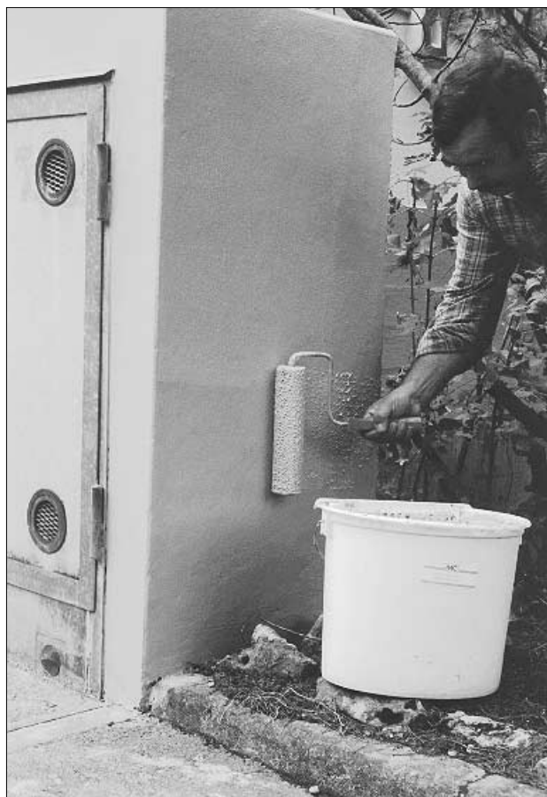
Figure 4.14 Application d'un enduit mince
