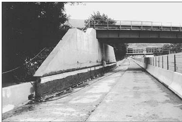
Figure 3.17 Culée de pont en réfection avec le procédé par déminéralisation électrochimique ECE
