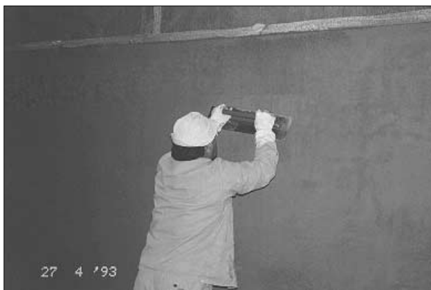
Figure 4.15 Travaux de finition à la main sur un enduit épais projeté
