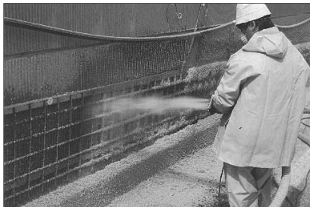
Figure 3.24 Projection d'enrobage du treillis-anode d'une réalcalinisation électrochimique
