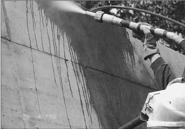
Figure 6.4 Projection de sable et d'eau, pas de formation de poussière, l'eau s'écoule à la surface du béton
