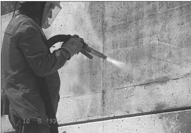
Figure 6.5 Projection de sable humide, pas de formation de poussière, la surface du béton n'est que légèrement humidifiée
