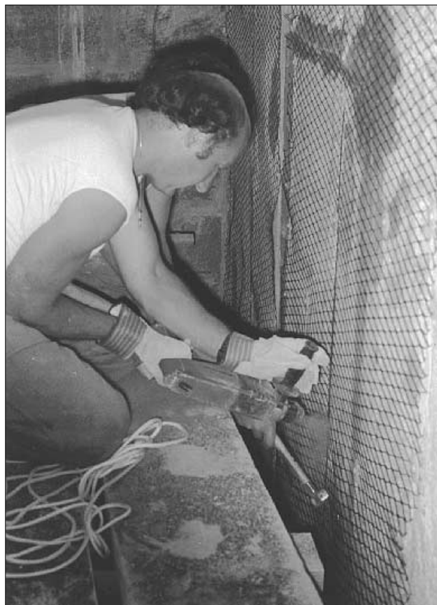
Figure 3.16 Montage du treillis-anode à la surface du béton
