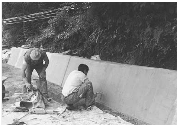
Figure 3.10 Application à la truelle d'un lissage bouche-pores
