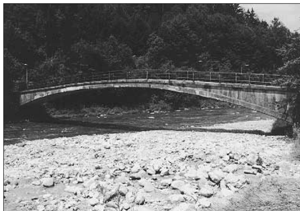
Figure 1.1 Pont en béton armé sur la Sihl, construit au début de l'utilisation du béton armé
