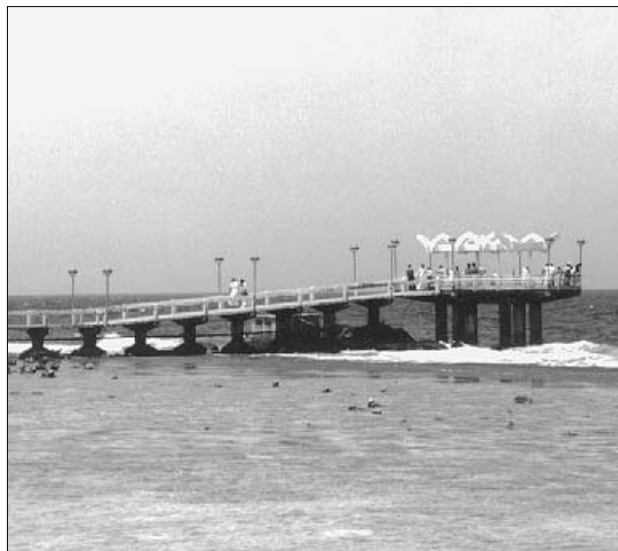
Figure 4.1 Les constructions en béton soumises à des conditions climatiques agressives - ici un embarcadère en mer fondé sur des piliers en béton - nécessitent des mesures de protection complémentaires pour garantir une protection durable contre la corrosion
