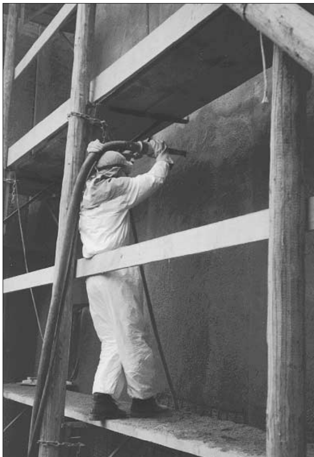
Figure 3.9 Réfection par application de béton projeté par voie sèche. Cette technique exige une largeur d'échafaudages importante!
