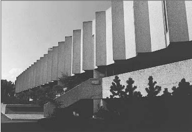
Figure 3.25 Exemple d'une façade traitée avec des inhibiteurs MFP
