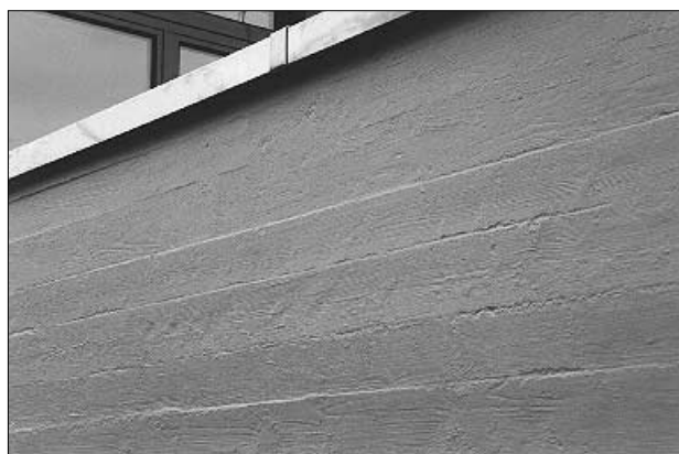
Figure 4.11 Surface de béton traité au glacis avec 4 % de pigments
