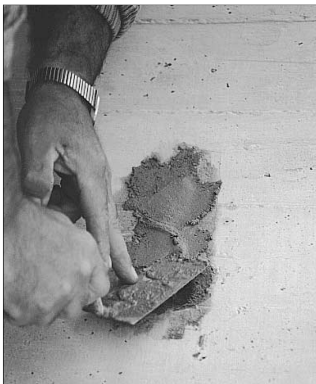
Figure 3.11 Reprofilage ponctuel au mortier
