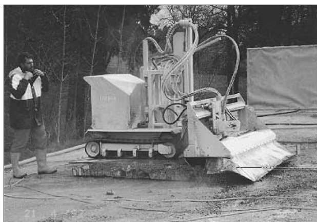
Figure 6.7 Jet d'eau à haute pression, 1'000 bars, exécution par un robot
