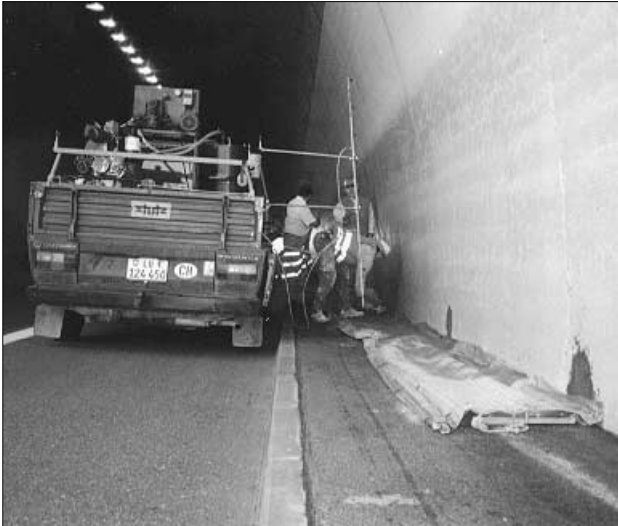
Figure 4.9 Application d'une imprégnation hydrophobe au moyen d'une installation de projection
