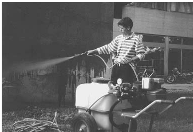
Figure 3.27 Application d'un inhibiteur sur une façade
