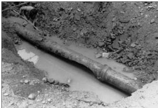
Figure 33: Conduite d'eau corrodée
