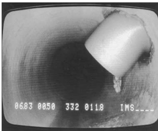
Figure 3.15: Les dépôts de sédimentation solides et les raccordements pénétrant dans les canalisations doivent être éliminés avant l'exécution des travaux d'entretien et de rénovation.
