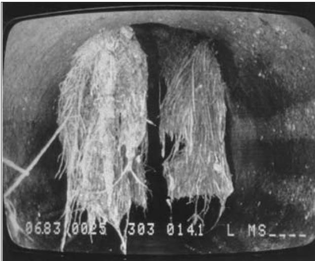
Figure 3.16: Les pénétrations de racines et leur développement entraînent des travaux de maintenance plus importants.
