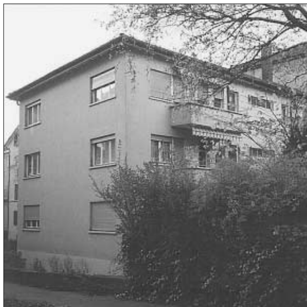
Photo 4.1: Façades sud et est
