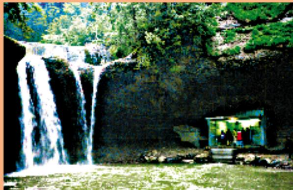
Petit aménagement hydraulique de 110 kW au Toggenbourg, remis en service en 1996 moyennant mesures de protection de l'environnement: p.ex. conservation de la digue datant de 1894, salle des machines munie d'un vitrage antibruit.
