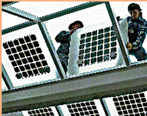
Ces plaques transparentes, dans lesquelles sont incorporées des cellules PV sont un exemple d'intégration au bâtiment d'un système PV qui laisse également passer la lumière naturelle.
