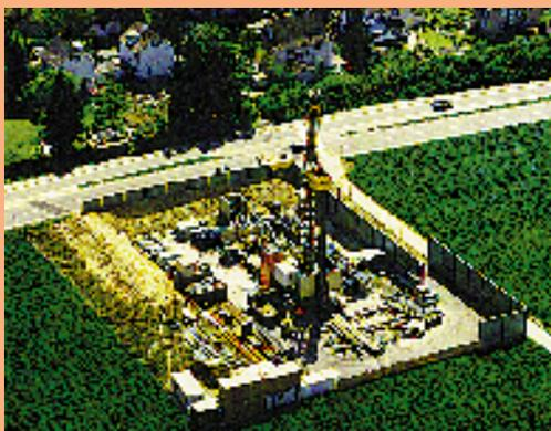
Les cloisons antibruit de l'installation de forage géothermique profond de Reinach, BL, étaient destinées à protéger les riverains du bruit des perforatrices. Une fois les travaux achevés, les lieux ont été remis dans leur état initial.
