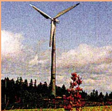
Éolienne de 150 kW, Obergrenchenberg (30 m de haut, diamètre du rotor 24 m, 140'000 kWh/an): démonstration de cette gamme de puissance, évaluation de l'impact sur le paysage.
