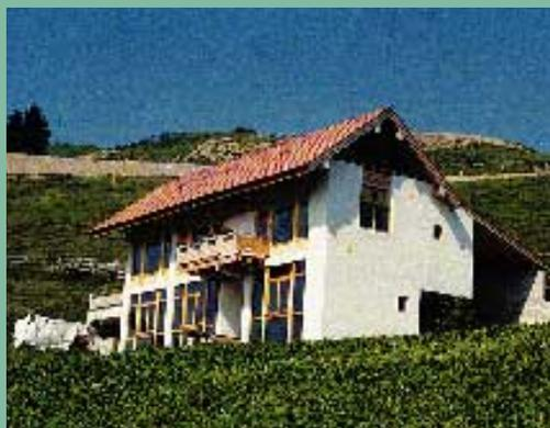
L'architecture traditionnelle n'interdit pas le recours à des éléments de construction peu gourmands d'énergie. Cette maison de Gonten stocke la chaleur des capteurs à air dans des dalles en béton.
