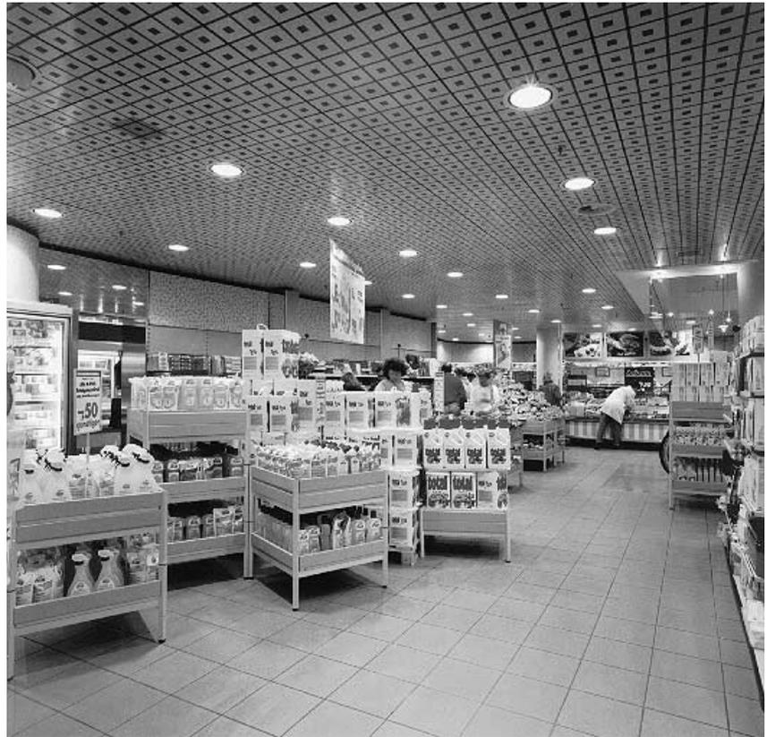
*Fig. 1.8 : Eclairage général par luminaires « downlights » à lampes compactes.*
