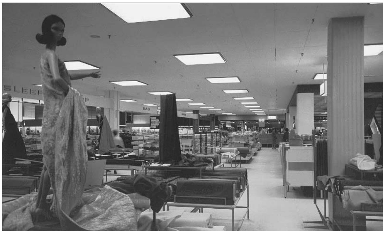
Fig. 1.1 : Vue de l'ancienne installation d'éclairage (luminaires opals 4 x 40 W)
