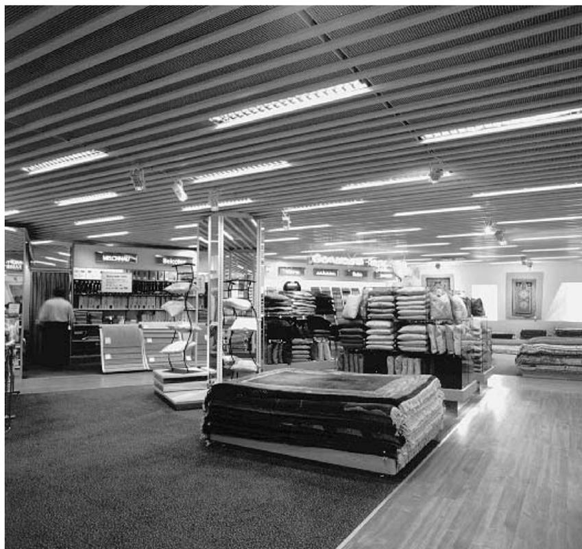
Fig. 1.7 : Eclairage général par luminaires monotubes à optique miroitée.
