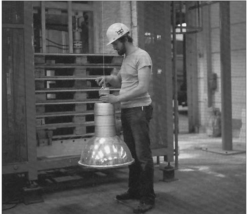
*Fig. 5.2 : Système de suspension des luminaires par fil (réduction des coûts d'entretien).*
