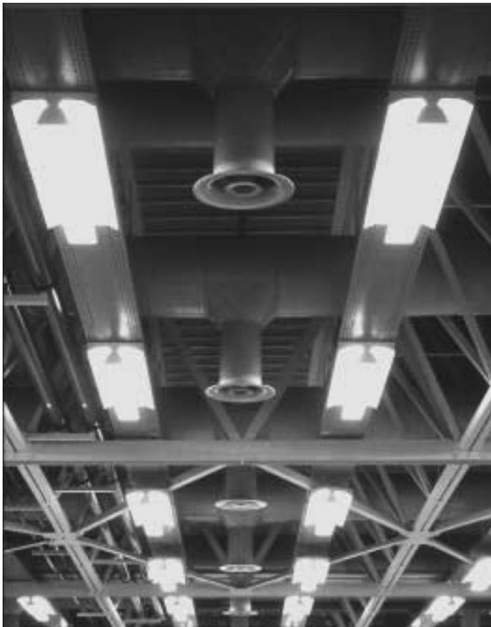
Fig. 2.4 : Eclairage direct/indirect intégré dans les luminaires.
