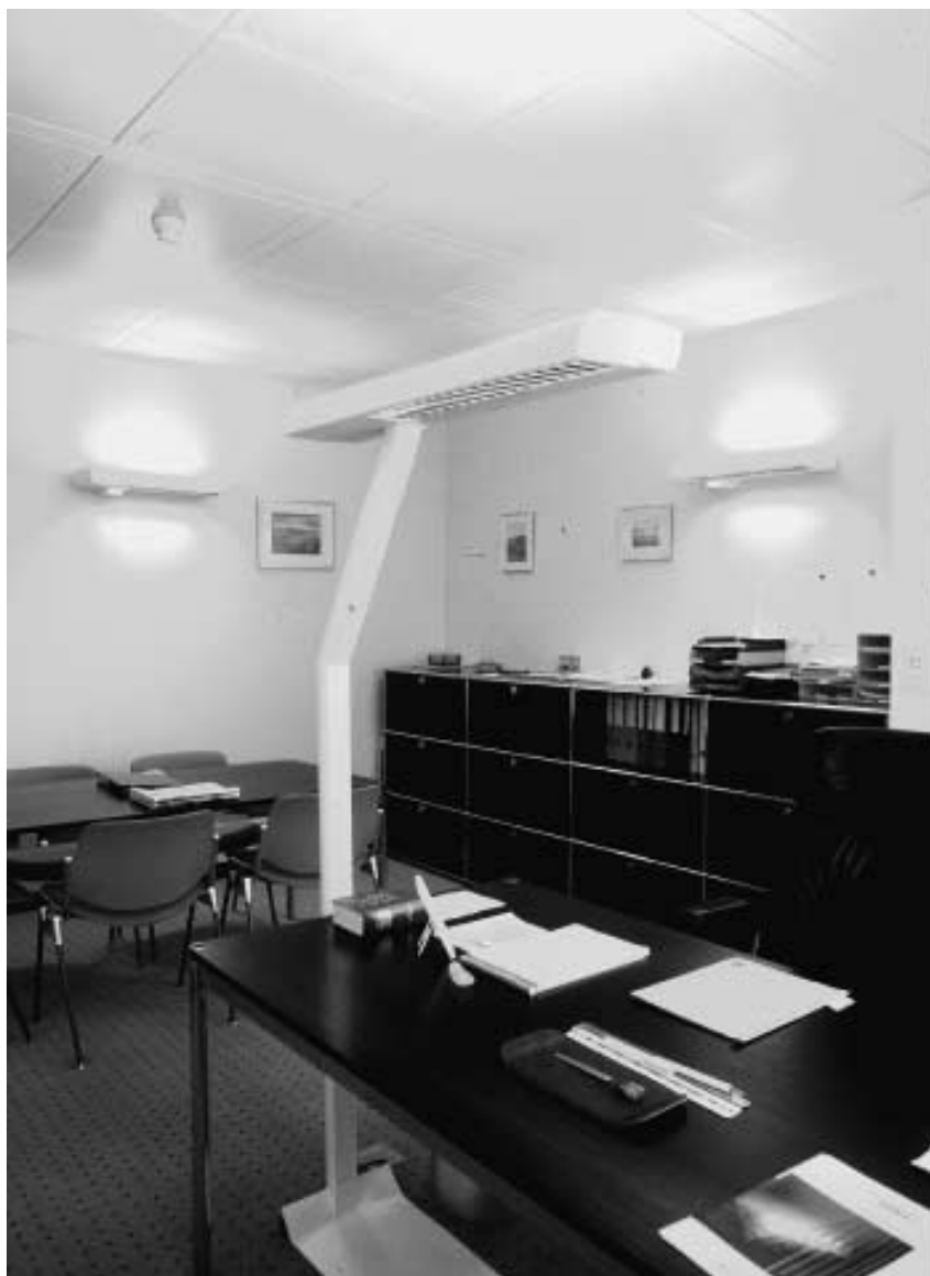
Fig. 0.1: Éclairage direct/indirect, par lampadaires mobiles et appliques d'appoint, dans un local de bureaux (gestion et administration)
