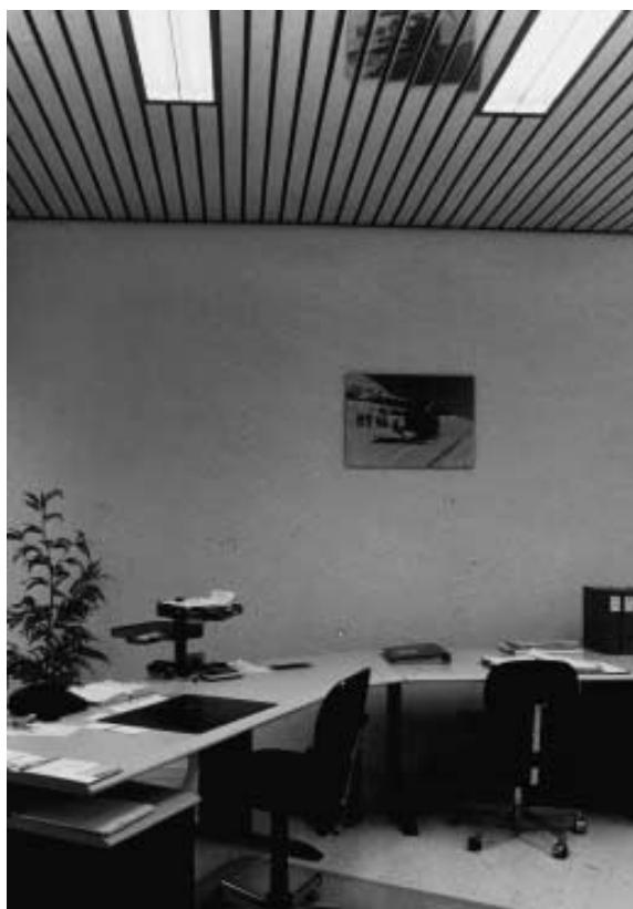
Fig. 3.6: Eclairage direct d'un bureau (luminaires à lamelles)
