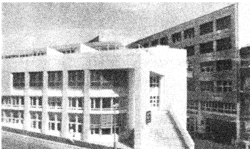
Figure 2.30: Vue générale du bâtiment
