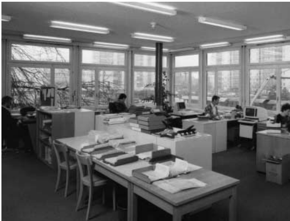
Figure 3.22: Vue de l'ancienne installation d'éclairage des bureaux
