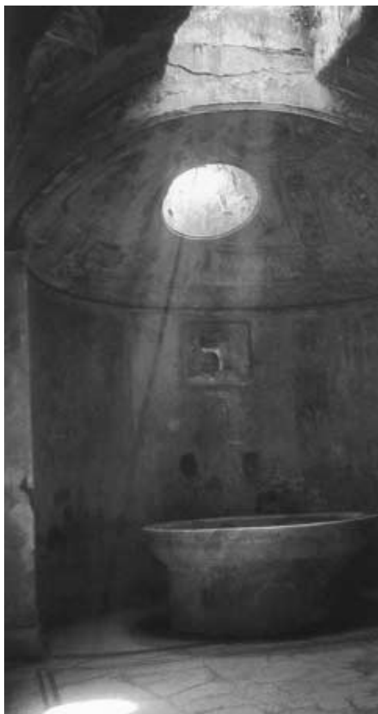
Figure 3.18: Fenêtre circulaire éclairant le labrum (bassin aux ablutions) dans le Caldarium (Thermes de Pompéi, architecte Vitruve): Un puits de lumière du jour rectangulaire permet d'éclairer le reste de la pièce.
