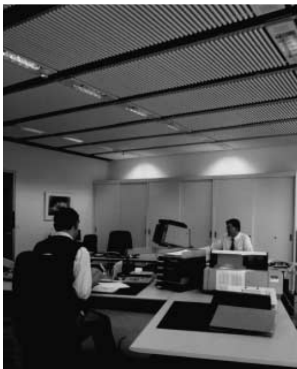
Fig. 3.11: Exemple d'un éclairage direct du type «Darklight» (bureau à écrans de visualisation).
