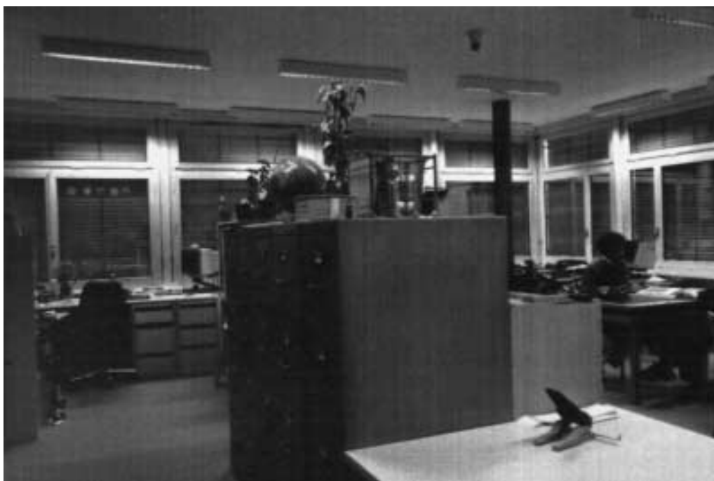
Figure 3.23: Vue de la nouvelle installation d'éclairage des bureaux
