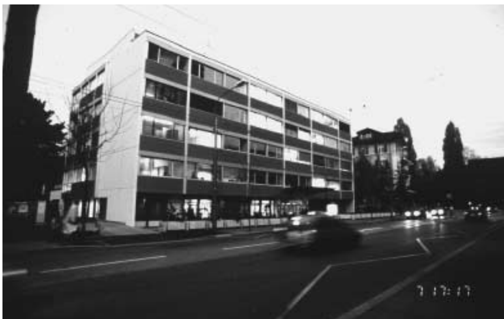
Figure 3.19: Vue du bâtiment de l'UAP à Lausanne
