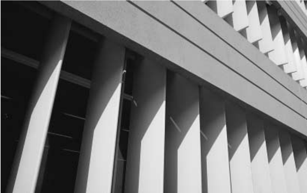
Figure 2.22: Élément de protection solaire fixe en façade sud (prise de vue hivernale: le rayonnement solaire n'est pas bloqué)
