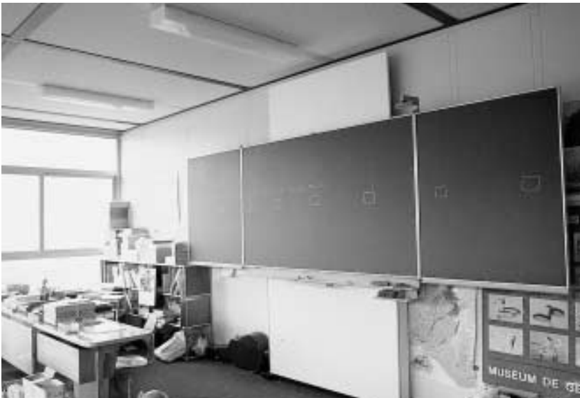
Figure 1.6: Situation d'inconfort visuel (éblouissement psychologique, voile de réflexion) provoquée par une ouverture inappropriée (fenêtre) et une surface de brillance excessive (tableau en verre).
