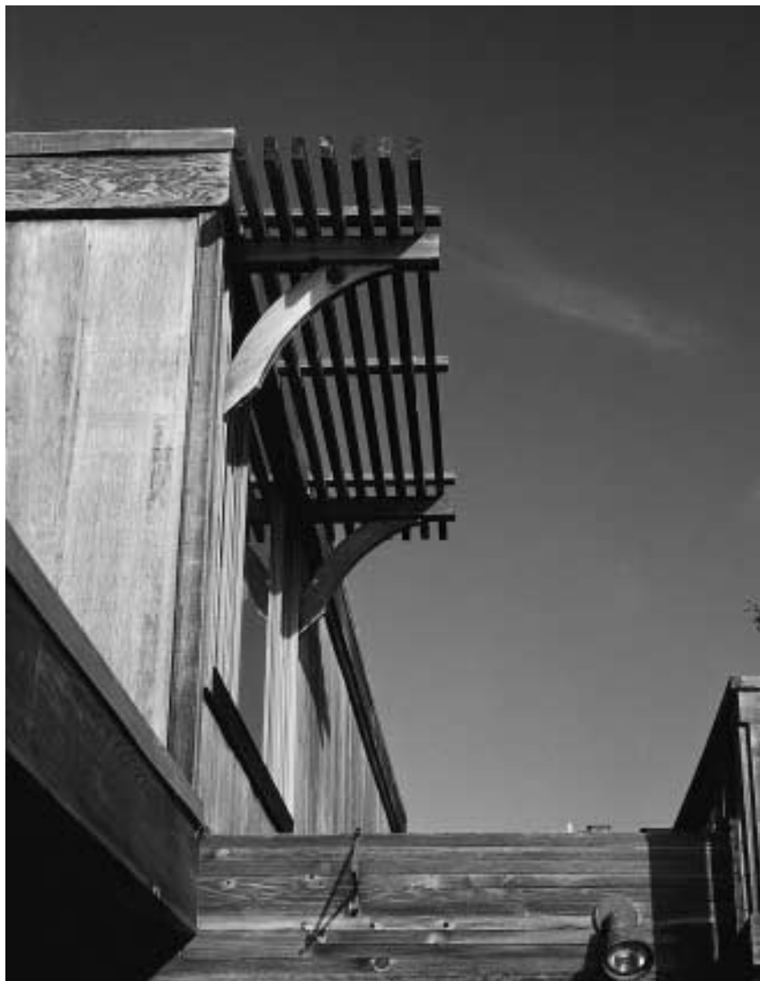
Figure 2.20: Élément de protection solaire fixe en façade sud (prise de vue hivernale: le rayonnement solaire n'est pas bloqué)
