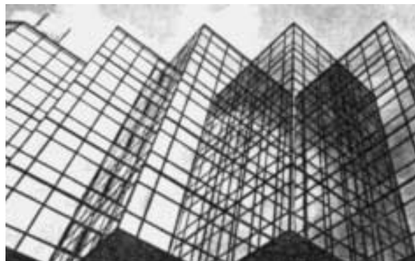
Figure 4.4: Bâtiment muni de façades entièrement vitrées (verres antisolaires)
