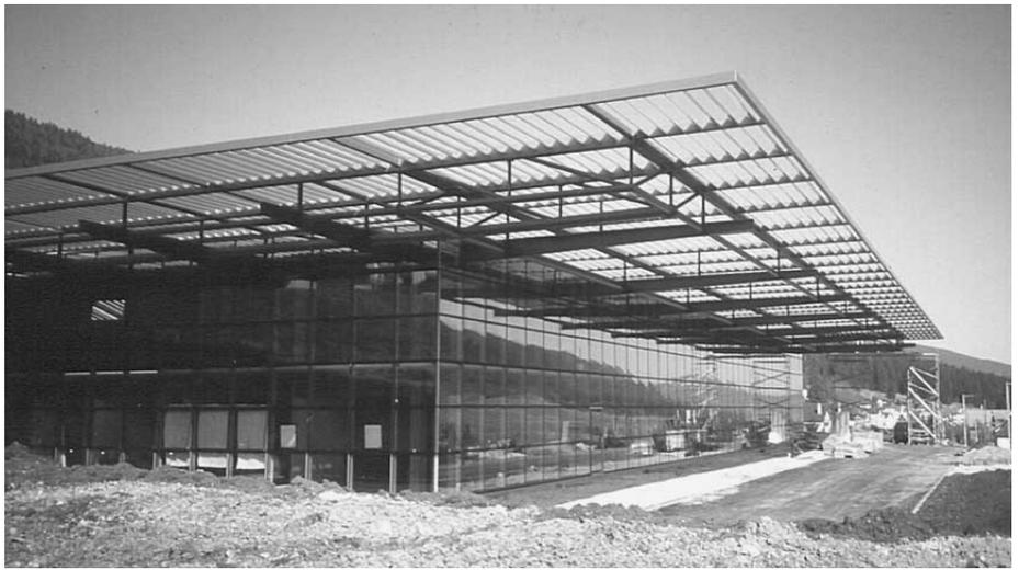
**Exemple extrême de protection solaire d'un bâtiment, réalisé à l'aide de lames horizontales fixes; la protection solaire n'est pas garantie sur les faces est et ouest (bâtiment Cartier, St.-Imier; architecte: Jean Nouvel, Paris).**
