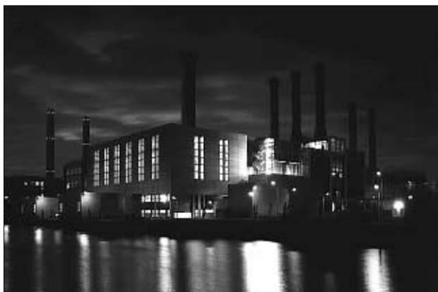
Figure 19: Centrale de chaleur-force combinée de « Merwedekanaal » près d'Utrecht en Hollande avec une puissance électrique de 225 MW.
