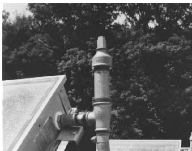
Figure c06 Exemple de purge des capteurs
