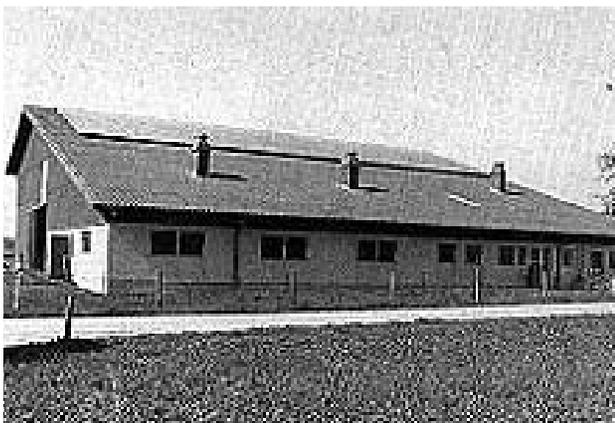
*Capteur en tôle d'aluminium placé sur une grange existante. La deuxième couche de poutres repose directement sur le toit en Eternit existant. Ce dernier est percé en son milieu, afin que l'air puisse passer dans le canal collecteur placé juste en dessous*
