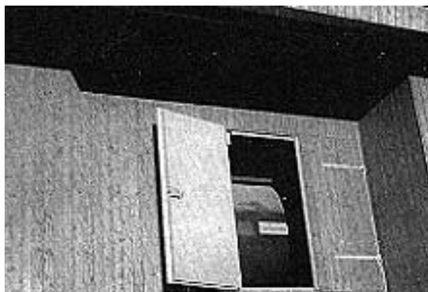
*Caisson de ventilateur placé entre la façade et la paroi de l'installation de séchage en grange. Une porte donne accès au ventilateur et permet l'apport d'air extérieur*
