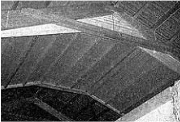
*Canal d'air passant par le faîte. Dans ce type de canal particulièrement long, il faut que la section soit suffisante pour éviter de trop grandes pertes de pression*
