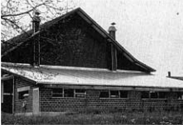
*Cette étable est couverte de polyester translucide (190 m<sup>2</sup>) servant de capteur solaire. L'air entre dans le capteur le long de la gouttière. Il monte, puis est dirigé depuis chacun des côtés vers le ventilateur placé au centre*
