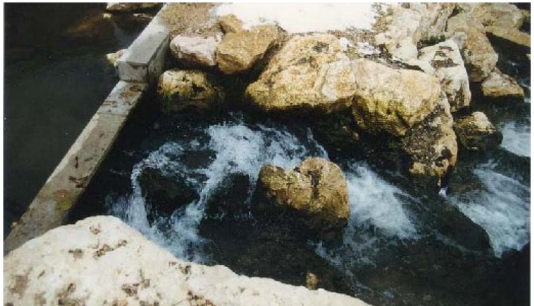
Durch geschicktes Plazieren von Blöcken und Steinen wurde der Uebergang ins Oberwasser so gestaltet, dass minime Fließgeschwindigkeiten herrschen und dadurch auch kleinste Organismen aufsteigen können.
