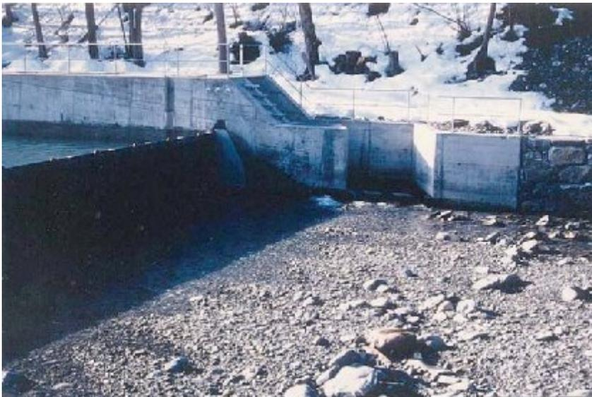
Direkt oberhalb des Einstiegs in den Fischpass wird zusätzlich Wasser eingeleitet, was die Lockwirkung der Anlage erheblich verstärkt.
