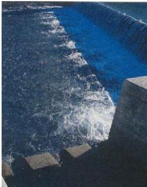
Der Eingang des Beckenpasses befindet sich direkt unterhalb des Tosbeckens und erfolgt über 3 Kronenausschnitte.
