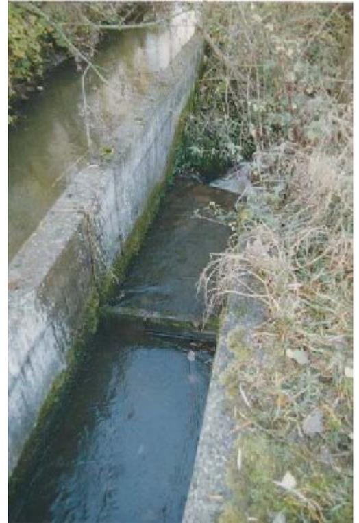
... gelangen die aufsteigenden Fische in einen Beckenpass, dessen Querwände mit Schlupflöchern (Öffnung im Bereich der Sohle) und Kronenausschnitten (Öffnung in der Oberkante) ausgestattet sind.
