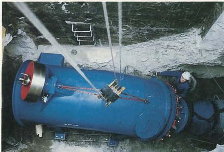
Mise en place de la turbine de la petite centrale hydraulique d'Obermühle, Baar.
