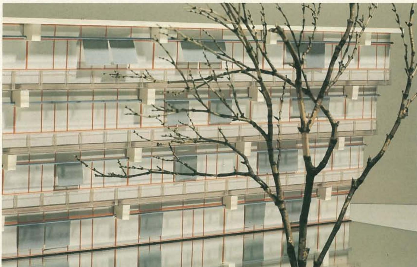
Cette façade de 4 étages est bien agencée pour capter la lumière naturelle qui se reflète dans le plan d'eau. Des arbres poussent sur le talus. On peut lire facilement la structure porteuse du bâtiment, au rythme des têtes de poutres espacées de 8 m. Les encorbellements servent également d'avant-toits qui apportent l'ombrage nécessaire aux étages inférieurs, ombrage qui peut être complété par un système de stores individuels.
