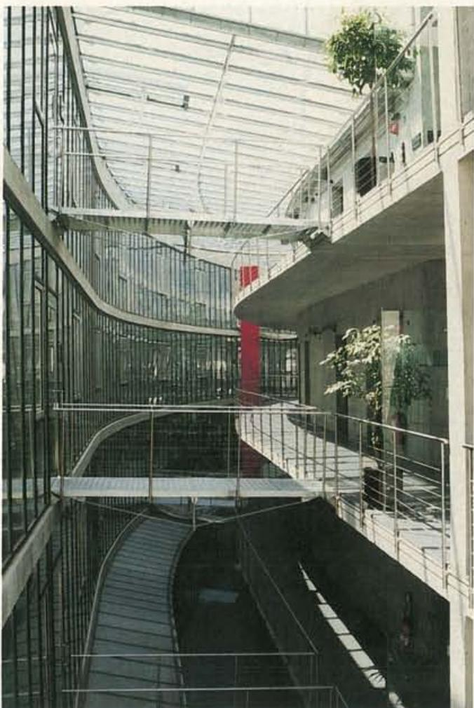
Une zone de déplacement centrale, traversante, a été placée dans ce canyon de lumière complètement vitré. Les galeries et les passerelles sont aussi éclairées que si elles étaient à l'extérieur. Une façade intérieure complètement vitrée permet aux bureaux de recevoir de la lumière naturelle par deux côtés à la fois.
