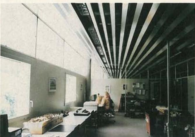
Des installations spéciales en façade et des réflecteurs placés au plafond des pièces permettent d'«étirer» la lumière jusqu'à l'arrière des bureaux. Le résultat en est un éclairage uniforme de l'ensemble du local.
