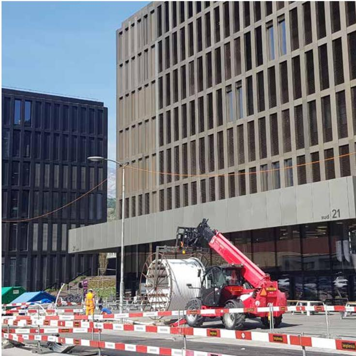
Les conduites blanches ont été posées dans le sous-sol à partir de la bobine et transportent désormais le CO<sub>2</sub>. Grâce à la section plus petite que celle des conduites d'eau, il a fallu creuser des fouilles moins profondes (source: HES-SO Valais-Wallis).
