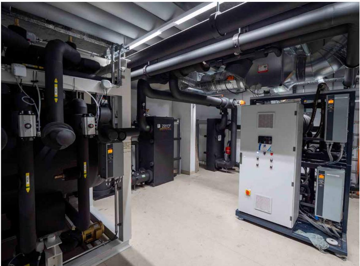
Dans la centrale énergétique du réseau d'énergie, l'eau souterraine refroidit ou réchauffe le CO<sub>2</sub> via un échangeur de chaleur (source: HES-SO Valais-Wallis)
