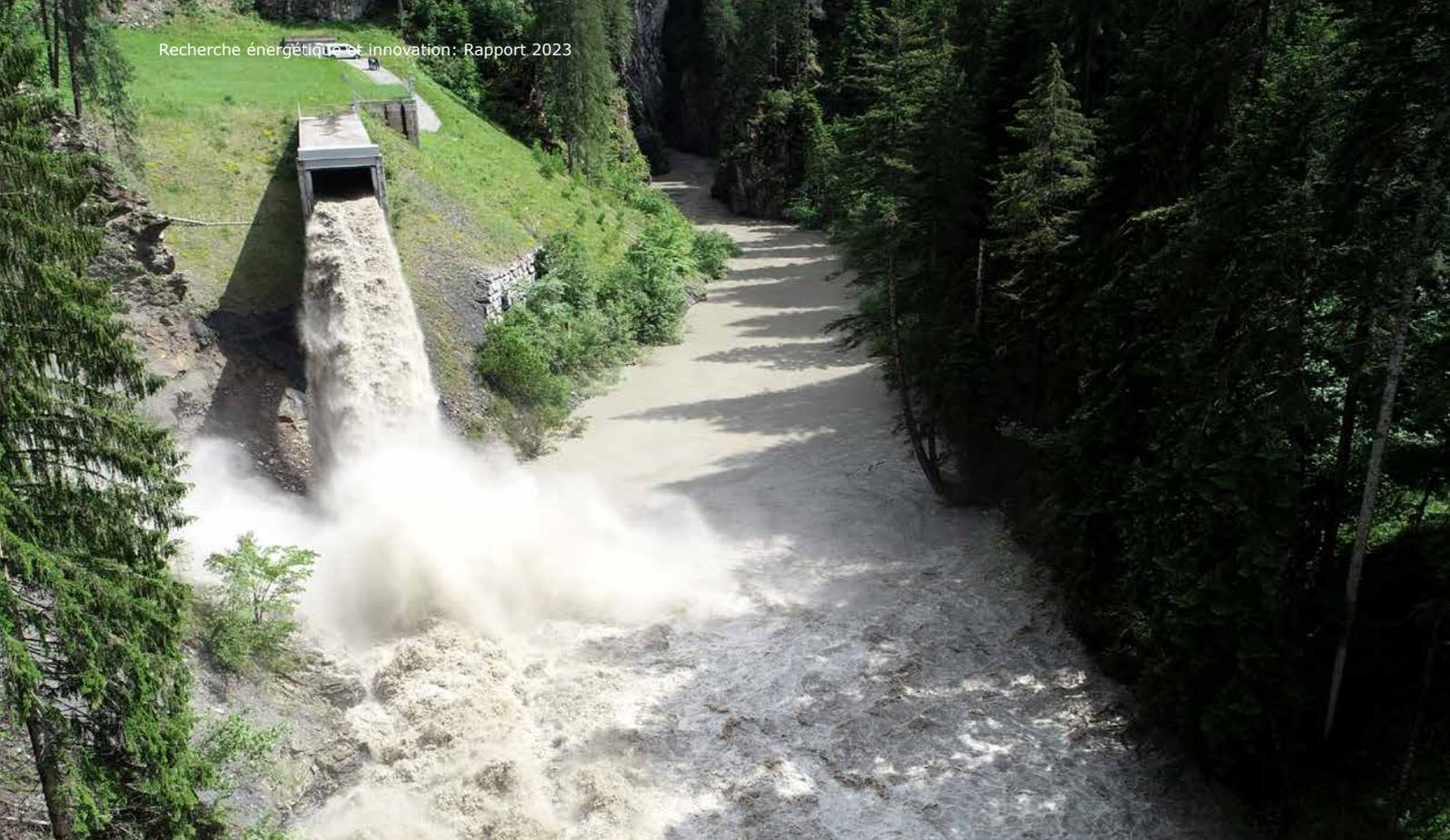
La sortie de la galerie de dérivation sur l'Albula, par laquelle les alluvions sont déviées le long du barrage de Solis (source: VAW EPF Zurich).
