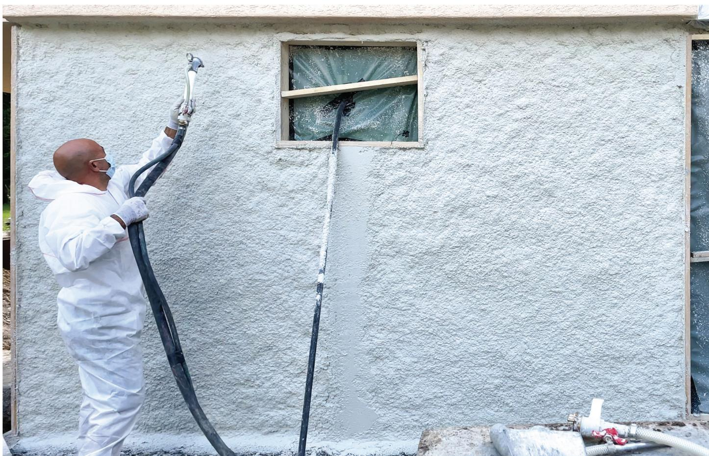
L'enduit isolant à base d'aérogel présente plusieurs avantages. L'un d'entre eux est qu'il peut être facilement appliqué sur les surfaces de façade irrégulières des bâtiments existants. Photo: Daniel Sanz Pont
