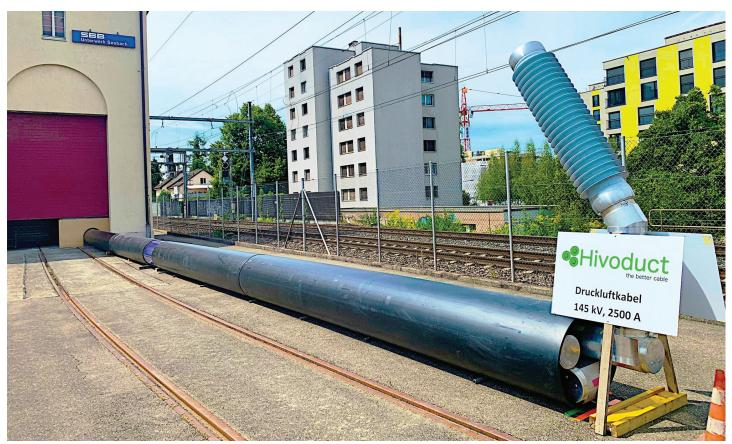
Partie de l'installation de démonstration pour les câbles à air comprimé au centre de commutation des CFF à Zurich-Seebach: on peut voir à droite de l'image que trois câbles à air comprimé sont logés dans le tube de protection. Chacun d'entre eux constitue une phase du câble haute tension triphasé. Même pendant les chaudes journées d'été et avec une intensité maximale de 2000 ampères, les câbles à air comprimé ne s'échauffaient pas à plus de 57°C. Photo : Hivoduct
