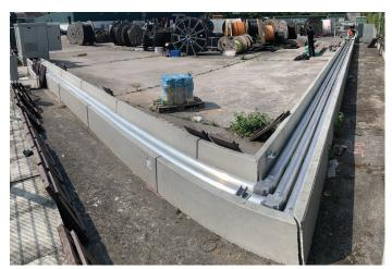
Câble à air comprimé moyenne tension (36 kV) avec trois phases juxtaposées, posé dans un canal de câbles. Photo: Hivoduct
