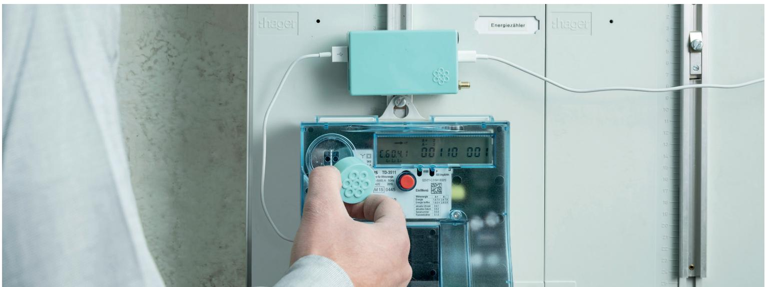
**Illustration 2 :** Une passerelle est montée sur le compteur électrique pour que la consommation d'électricité en temps réel soit simultanément disponible sur l'application. Les passerelles sont gratuites pour les client-es «cleverStrom». (Photo: ibw)
