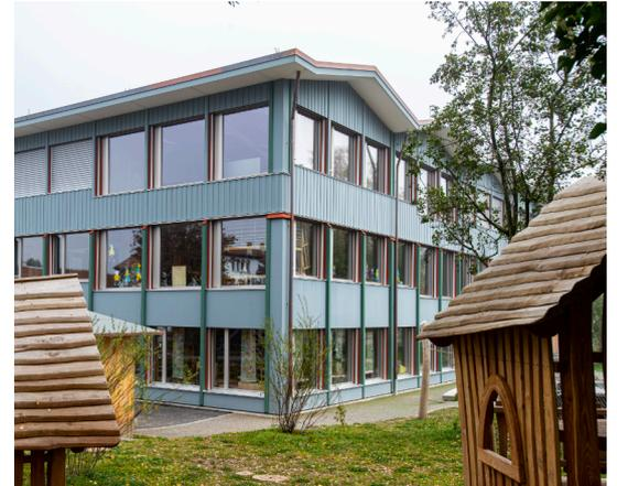
Le matériau de construction bois contribue à la réalisation de l'objectif zéro émission nette. Photo: Établissement scolaire à Fällanden (ZH) composé de modules préfabriqués en bois. Photo: Primin Jung Schweiz AG
