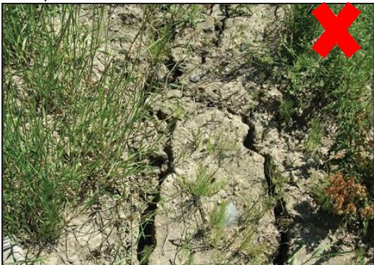
Fissures longitudinales qui indiquent des tassements du remblai (photo: FEMA, 2016).
