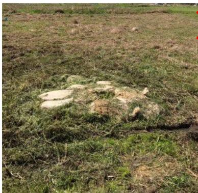
Sortie de matériaux fins à l'aval du remblai (sandboils)
