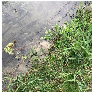
Sortie de matériaux fins dans un canal pour eaux d'infiltration à l'aval du remblai (photo: inspection OFEN)
