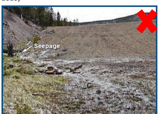
Infiltrations le long des appuis du barrage (photo: FEMA, 2016)
