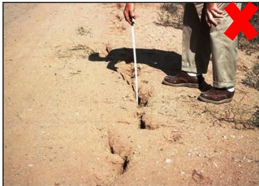
Fissures longitudinales qui indiquent des tassements ou instabilités du remblai (photo: FEMA, 2016).
