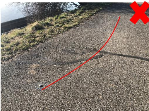
Tassements du couronnement qui indiquent un matériau faible ou une érosion possible dans le remblai ou dans la fondation (photo: inspection OFEN)
