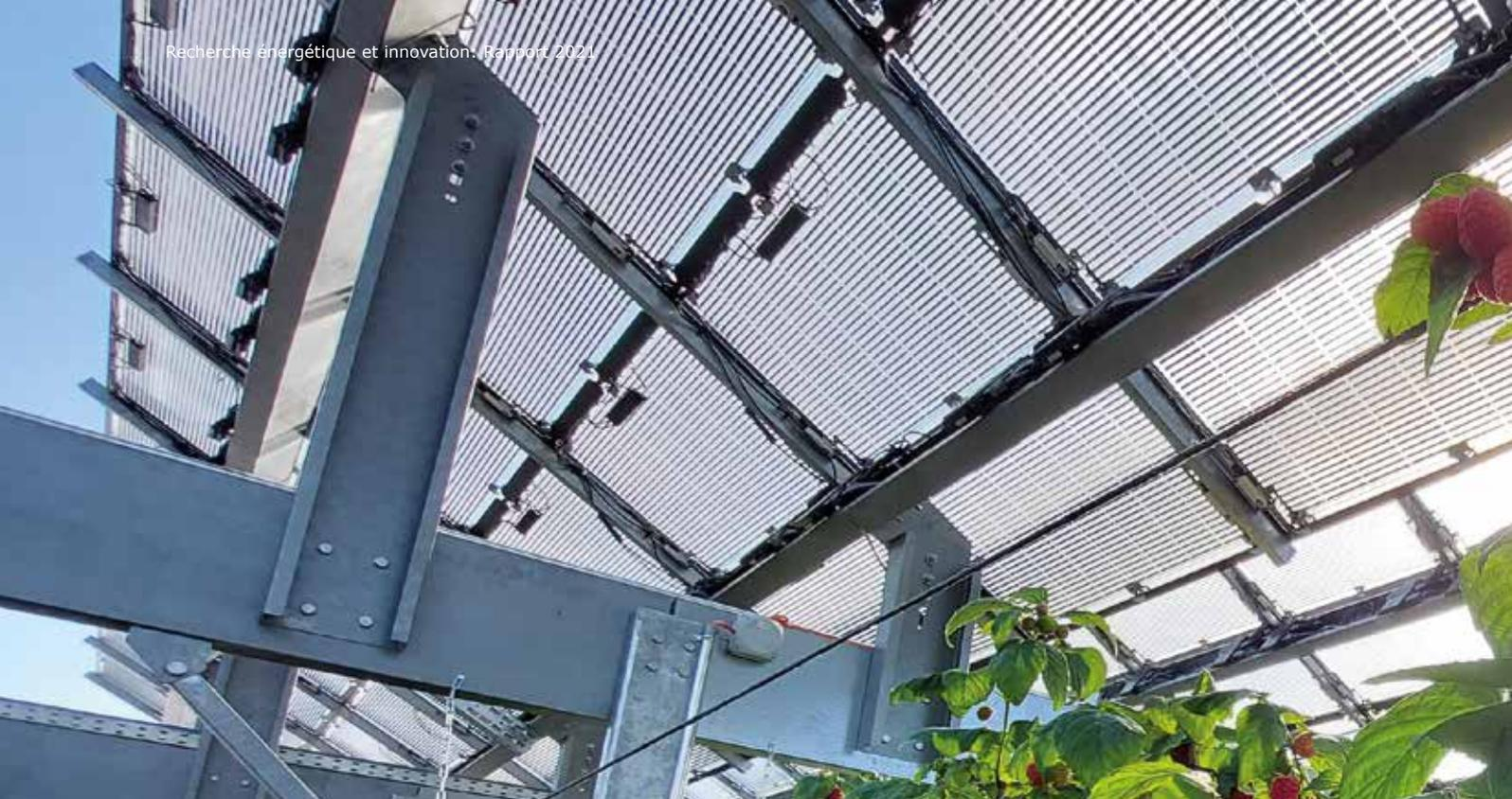
Installation pilote photovoltaïque sur le site de recherche Agroscope à Conthey (VS), où des modules à transparence modulable sont installés au-dessus d'une culture de framboises, afin que les plantes poussant en dessous soient plus ou moins ombragées. Les modules solaires ont été spécialement conçus pour de telles applications par l'entreprise suisse Insolight (source: Agroscope).
