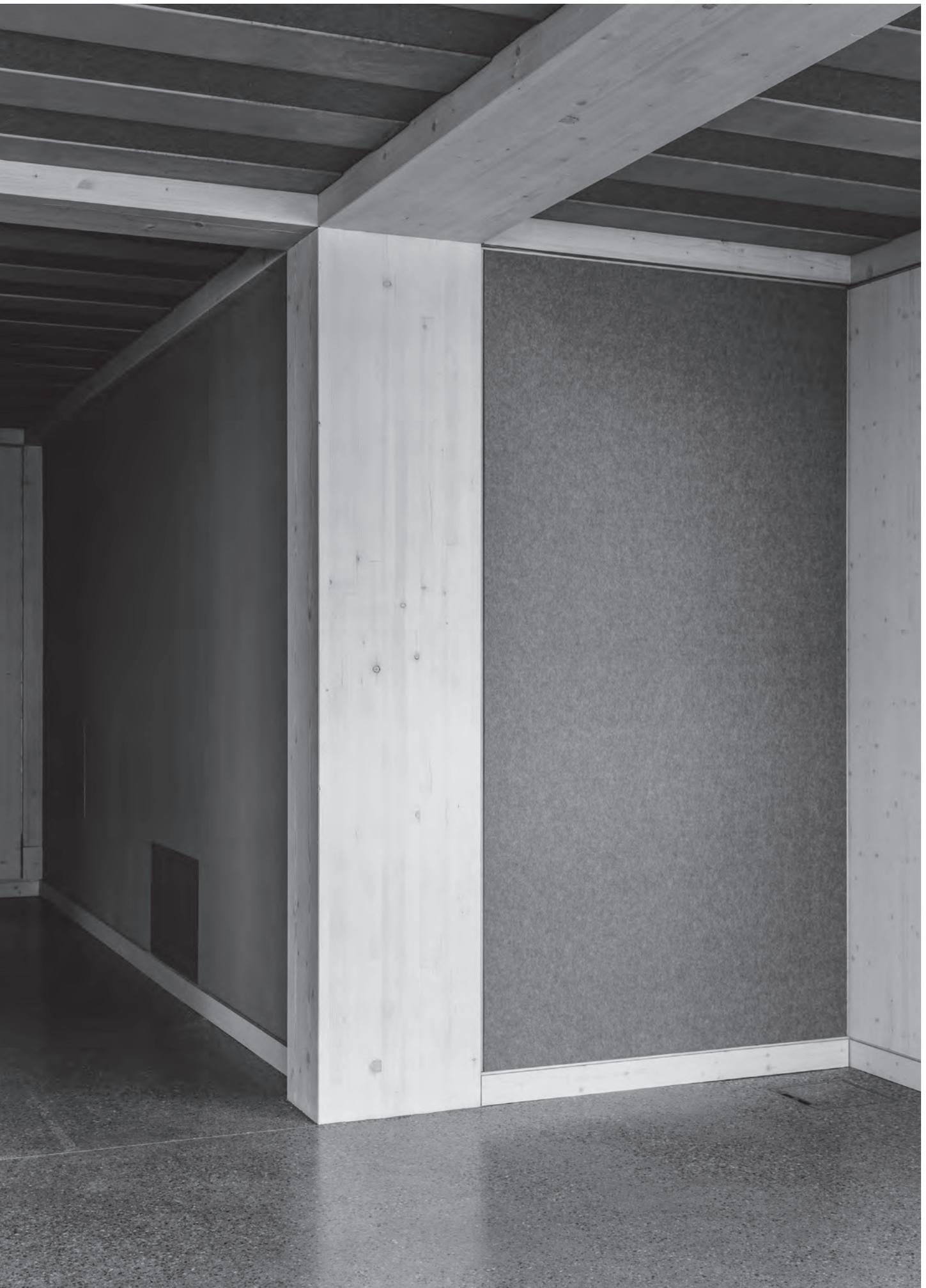
Les poteaux et les poutres en bois ainsi que les bandes du plafond en béton et en feutre: la construction structure les surfaces.
