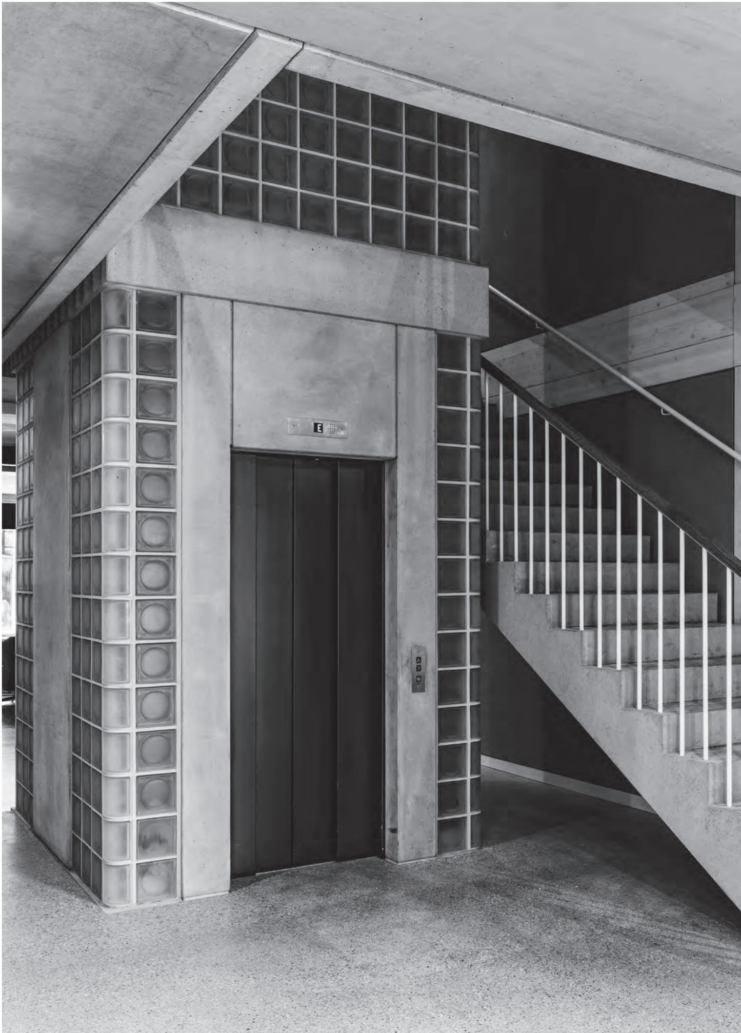
La cage d'ascenseur dans la cage d'escalier avec des murs en briques de verre.
