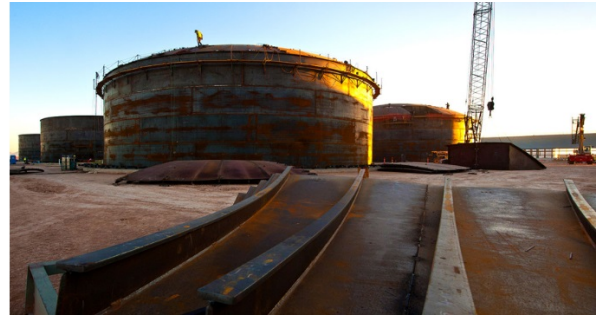
Figure 32: Centrale solaire thermique à concentration «Solana» d'Abengoa Solar dans le désert de l'Arizona (États-Unis) avec puissance de raccordement de 250 MW (à gauche). Elle utilise 125 000 tonnes de sel fondu (60% de nitrate de sodium \text{NaNO}_3 et 40% de nitrate de potassium \text{KNO}_3 ) pour stocker 1,68 GWh d'énergie thermique pendant 6 heures en pleine charge sans rayonnement solaire (à droite). En Suisse, des activités de recherche portant sur ce type de stockage à haute température sont menées dans le cadre de projets européens (CSP Eranet).
