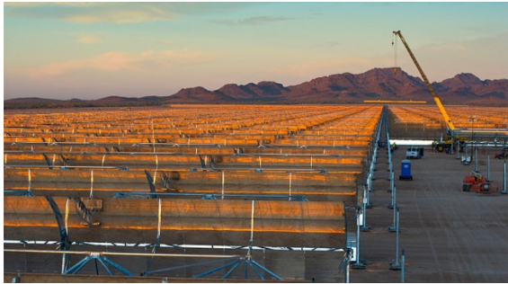
Figure 32: Centrale solaire thermique à concentration «Solana» d'Abengoa Solar dans le désert de l'Arizona (États-Unis) avec puissance de raccordement de 250 MW (à gauche). Elle utilise 125 000 tonnes de sel fondu (60% de nitrate de sodium \text{NaNO}_3 et 40% de nitrate de potassium \text{KNO}_3 ) pour stocker 1,68 GWh d'énergie thermique pendant 6 heures en pleine charge sans rayonnement solaire (à droite). En Suisse, des activités de recherche portant sur ce type de stockage à haute température sont menées dans le cadre de projets européens (CSP Eranet).
