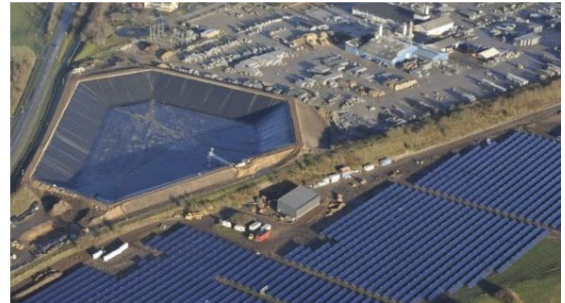
Figure 27: Au Danemark, on utilise de grandes fosses de stockage thermique saisonnier (Pit storage) en combinaison avec les réseaux de chauffage et l'énergie thermique solaire. En 2020, la part des bâtiments chauffés par un réseau de chaleur à distance atteignait déjà 66%. En cas de volume important (100 000 m 3 et plus), les coûts du stockage baissent et se situent autour de 30 francs/m 3 . L'utilisation de l'eau en tant qu'accumulateur sensible permet une bonne stratification avec une capacité thermique élevée. Dans les grands accumulateurs, les déperditions de chaleur sur une année sont inférieures à 10% (source de l'image de droite: Vojens Fjernvarme).
