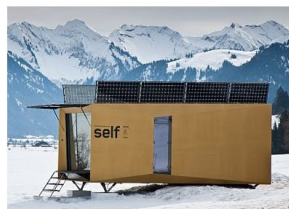
Cellule d'habitation autosuffisante en énergieSELF, Empa (2009–...)
