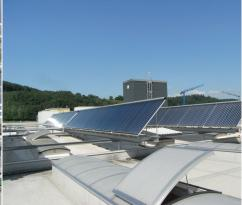
Fromagerie de Saignelégier) concentrent le rayonnement solaire sur un tube absorbeur dans lequel circule de l'eau et qui chauffent le direct et diffus. Ils se différencient des capteurs pour le chauffage d'un fluide caloporteur (ici: fluide caloporteur jusqu'à 112°C. Les capteurs à tubes sous vide par leur rendement élevé utilisent le rayonnement direct, mais pas le rayonnement diffus. Photo: SPF
