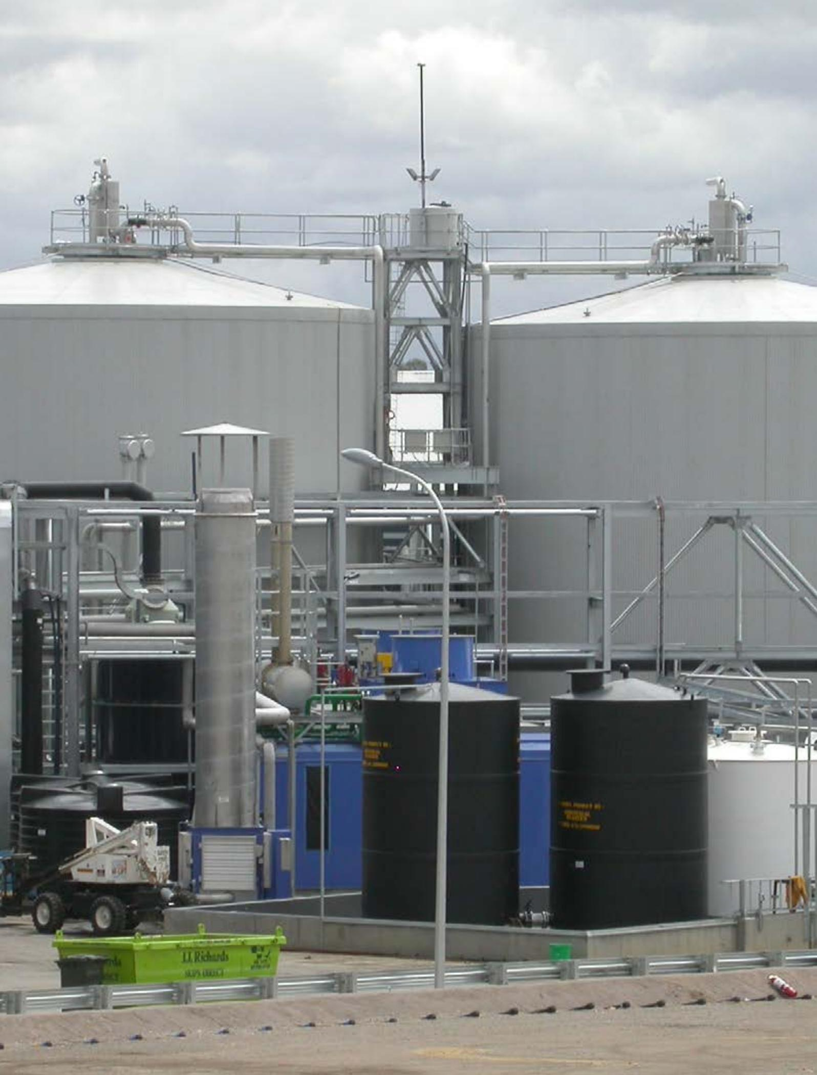
Fig. 9: Traitement de lixiviats de déchets verts dans un réacteur hybride (partie inférieure UASB, partie supérieure filtre anaérobie).
