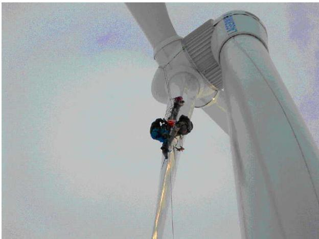
**Figur 3:** Reparatur des Rotorblattes der Anlage Gütsch im Dezember 2003
