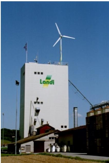
**Figur 2:** Eine 7 kW-Windkraftanlage auf dem Silo der landwirtschaftlichen Genossenschaft in Marthalen
