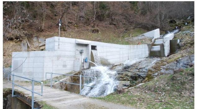
Das Kleinwasserkraftwerk Anzonico-Vigne erzielt durch den Höhenunterschied von 430 Meter eine Leistung von 230 kW. Es nutzt das Wasser vom Bach "Ri di Suàisa", welches auf der linken Talseite der Leventina liegt.
