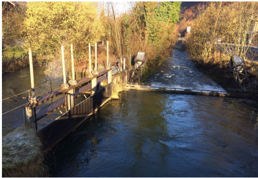
Abbildung 2-4 Seitenentnahme (links) mit beweglichem Segmentwehr
