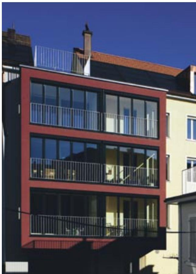
*Der neue Verbindungsbau mit den verglasten Loggias bringt mehr Wohnfläche und dient als energetische Pufferzone. (Nina Mann)*
