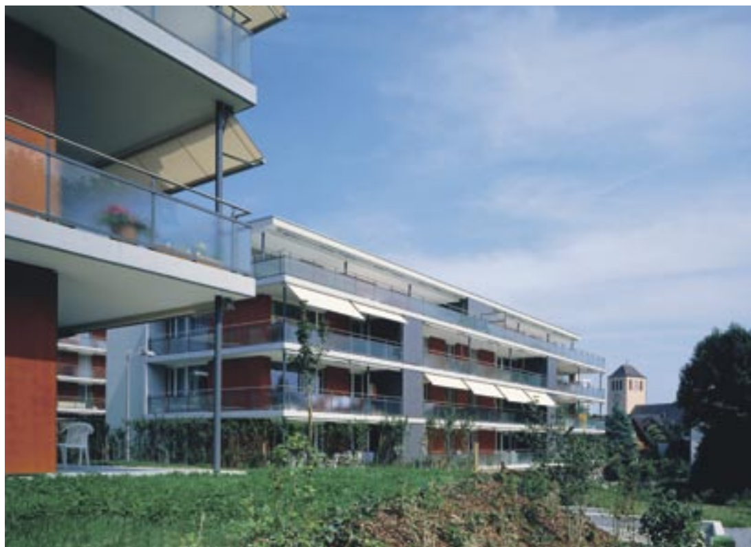
Die ersten Minergie-P-Mehrfamilienhäuser in Massivbauweise stehen im luzernischen Rothenburg.
