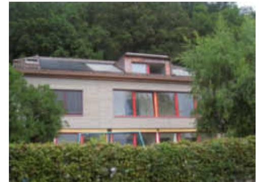
**Thermische Brücken sind Schwachstellen der Gebäudehülle. Bei der Modernisierung des Einfamilienhauses wurden sie durch Baumassnahmen beseitigt, die unter anderem eine Vergrösserung der Wohnfläche ermöglichten. Eine erhebliche thermische Brücke verursachte beispielsweise der Balkon. Das Problem wurde durch das Vorsetzen der Glasfassade vor dem Balkon gelöst. Die Energiebezugsfläche des modernisierten Einfamilienhauses beträgt total 388 Quadratmeter.**
