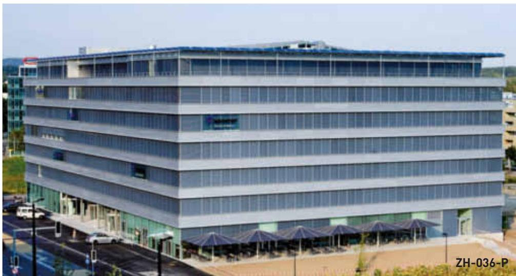
metern Energiebezugsfläche ist es das bisher grösste MINERGIE-P®-Gebäude in der Schweiz. Das intelligente Gebäudekonzept umfasst die Kernpunkte: kompakte Gebäudeform, ausgezeichnete Wärmedämmung, Fernwärme für Gebäude und Warmwasseraufbereitung des Restaurants, energieeffiziente Lüftungstechnik mit Wärmerückgewinnung, energieeffiziente Kältetechnik und Erzeugung von Strom mittels Fotovoltaik.
