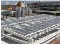
Demonstrationsanlage bei COLAS in Genf mit 20 Kollektoren und den damit erwärmten Bitumen-Tanks im Hintergrund. (Foto: COLAS)
