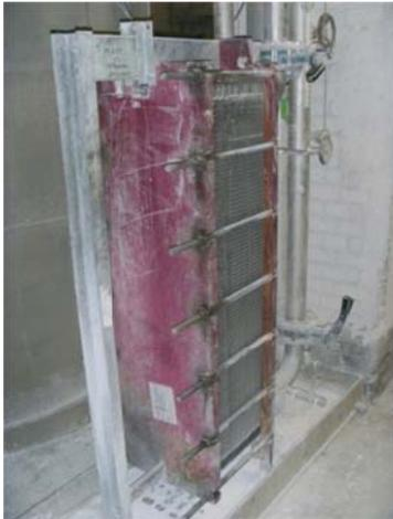
**Grafik 3:** Wärmetauscher für die Wärmerückgewinnung aus Washwasser
